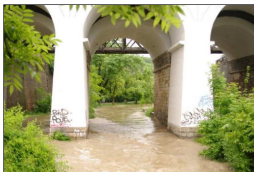
Obr. 3: Železniční viadukt u Rokytky [5]
