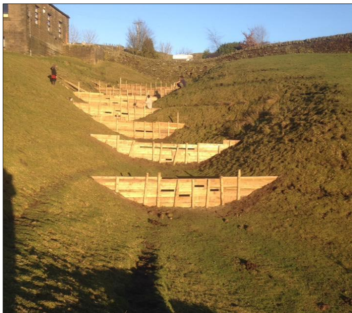
Obr. 55: Ilustrační fotografie kaskády hrázek v přirozené svodnici [63]
