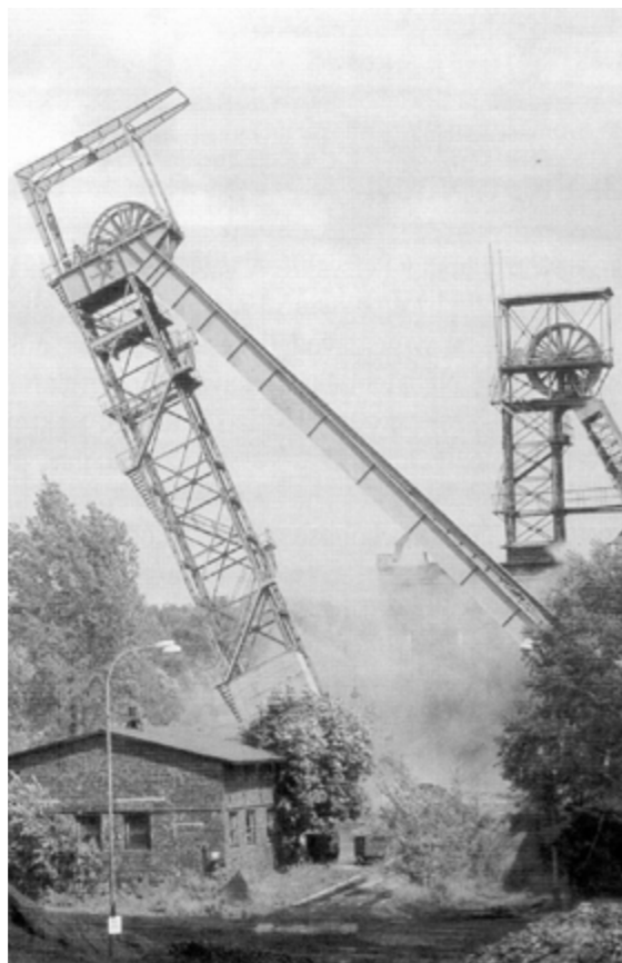
odstřel těžební věže dolu Fučík
