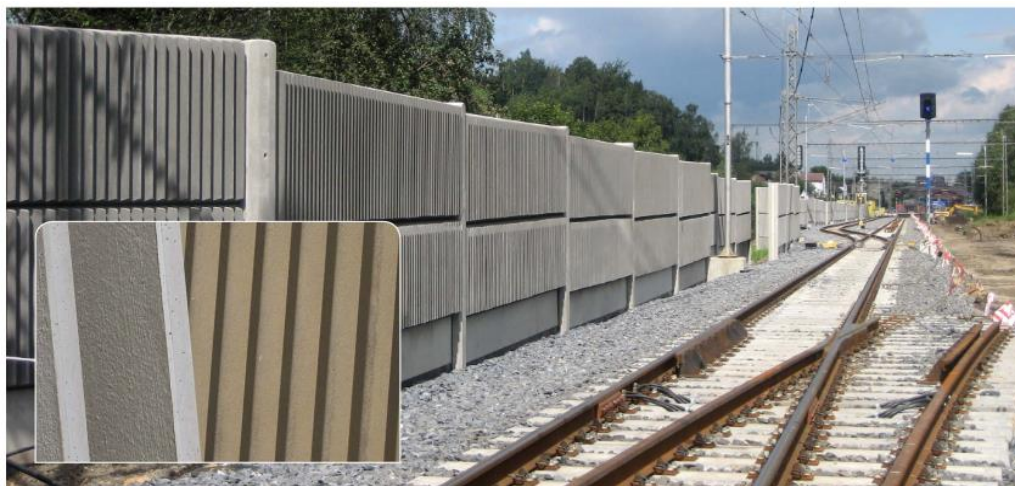
Obr. 25 Betonová protihluková stěna ŽPSV SILENT [101]
