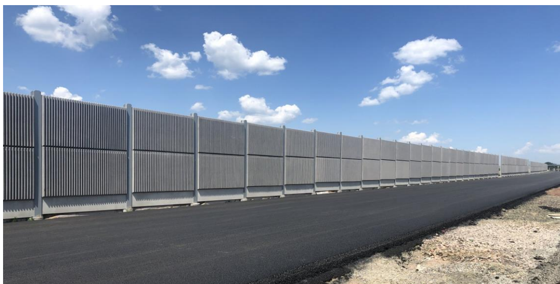
Obr. 26 Betonová protihluková stěna Liadur [102]
