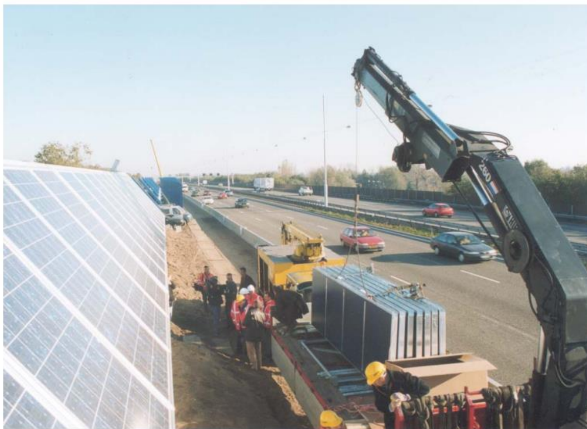
Obr. 10 Montáž fotovoltaické protihlukové stěny na dálnici A9 v Nizozemsku [82]
