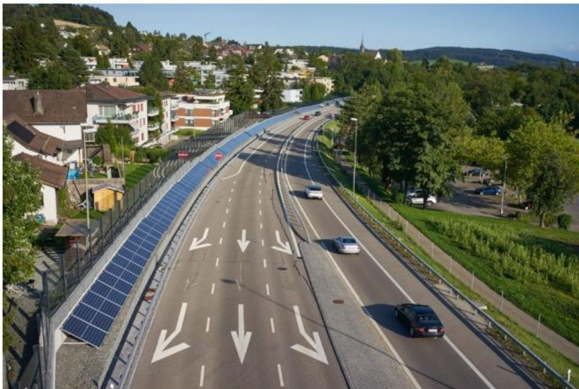
Obr. 9 Fotovoltaická protihluková stěna ve Švýcarsku [2]
