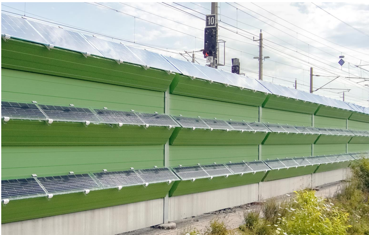
Obr. 37 Příklad fotovoltaické protihlukové stěny s trojřadou kazetovou konstrukcí Forster FONOCON Silent Solar na železnici v Rakousku [108]
