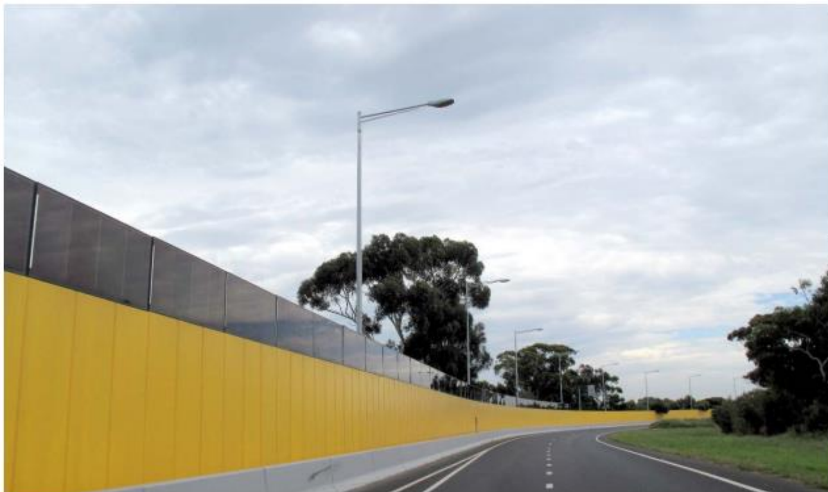
Obr. 11 Fotovoltaické moduly na prefabrikované betonové protihlukové stěně v Melbourne (Austrálie) [68]
