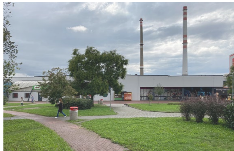
Obr. 2 Supermarket na nároží ulice U Plynárny (zdroj: autor)
