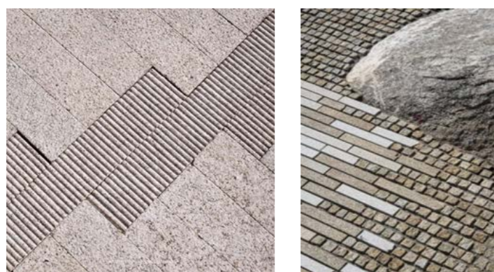
Portland Oregon použití kombinácie dvoch prvků v kresbě žulovej dlažby, hra s materiálom - prechod žulovej dlažby do neopracovaného kameňa
