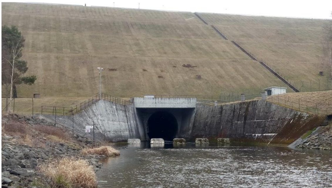
Příloha 2 – Pohled na hráz VD Želivka [fotografie autora]
