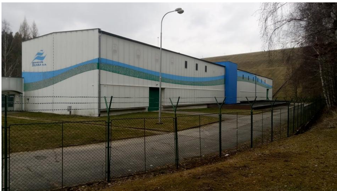
Příloha 3 – Úpravna vody Želivka [fotografie autora]
