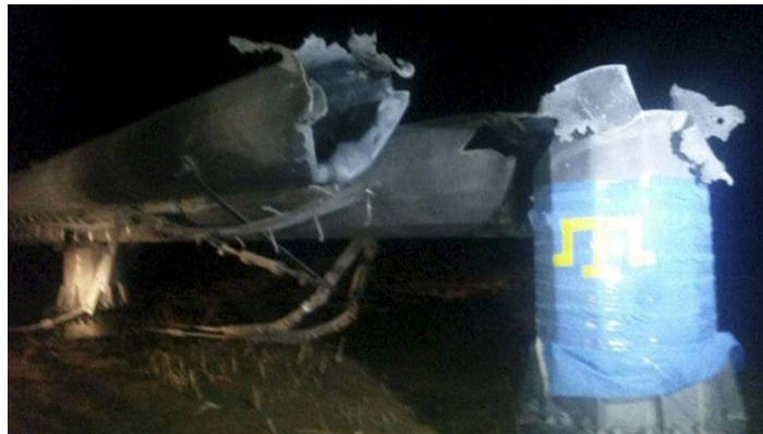
Obrázek 4 Poškození stožáru vysokého napětí (Radiožurnál 2015)
