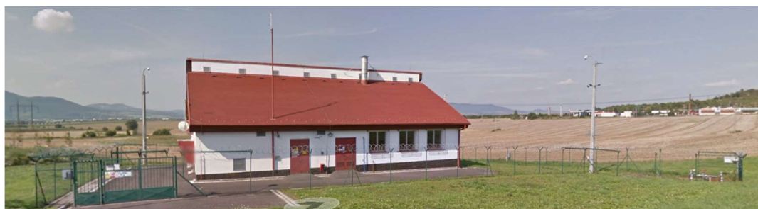
příloha 5 - Budova plynové stanice GasNet (zdroj:[27])
