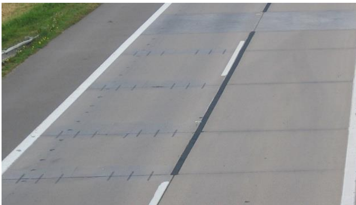
Obrázek 6: Vozovka s cementobetonovým krytem s viditelnými spárami
