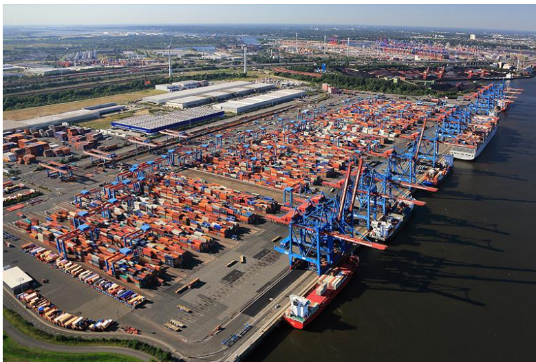
Obrázek 4 - Kontejnerový terminal Altenwerder [17]
