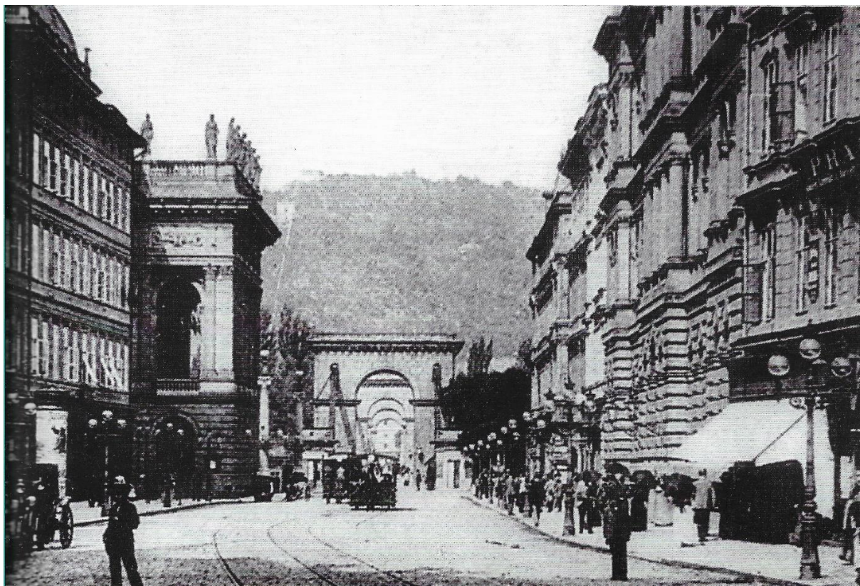
Obr. 3 Stanice koňky u Národního divadla. V pozadí řetězový most císaře Františka I. [1]
