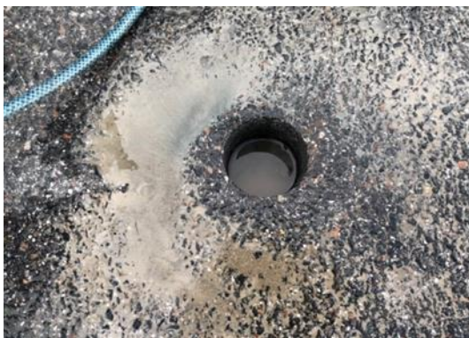
Obrázek 16 – Jádrový vývrt pro dopravní klasifikátor (Beneš, 2020)
