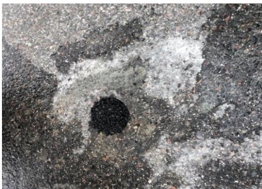
Obrázek 18 – Zaasfaltování otvoru studenou asfaltovou směsí (Beneš, 2020)
