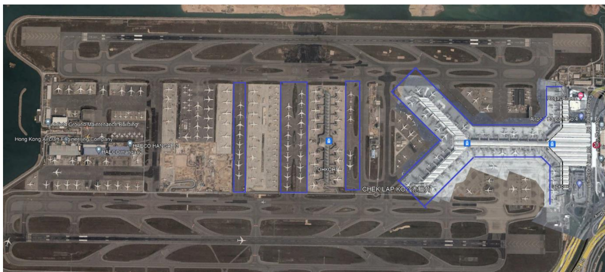
Obrázek 6: Skladování letadel na letišti Hong Kong International Airport na začátku roku 2020. Modrá plocha označuje dodatečná místa pro parkování na pojezděcích drahách a vedle nástupních mostů. Aplikace Google Earth.
