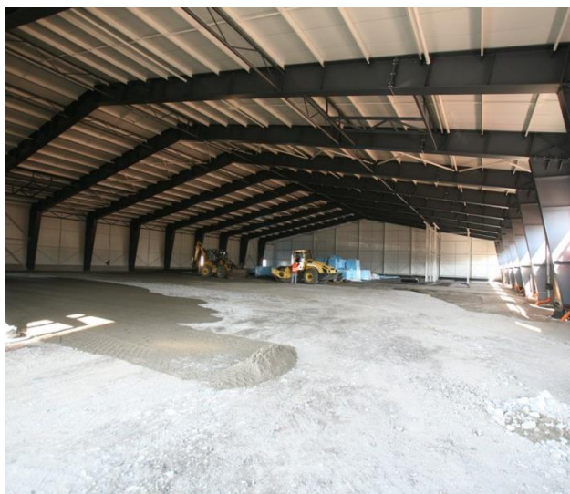
Obrázek 22: Plnostěnná konstrukce výrobní haly [22]
