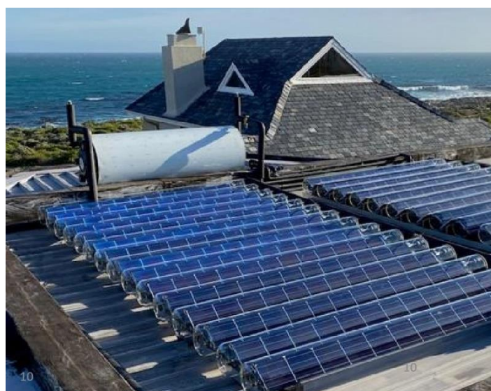
Obrázek 6.2 Instalace VirtuPVT se zásobníkem vody [13]
