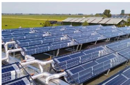
Obrázek 3.3 Koncentrační FVT kolektory v Holandsku [2]
