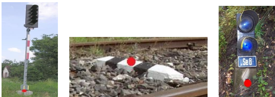
Obrázek 9 – Návěstidlo světelné stožárové, námezník, návěstidlo trpasličí [1]
