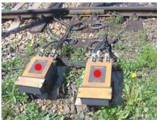
Obrázek 10 - konec kolejového obvodu, přestavník + záporník a pražce [1]
