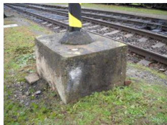
Obrázek 12 – sokl, kolejnicové zarážedlo [1]
