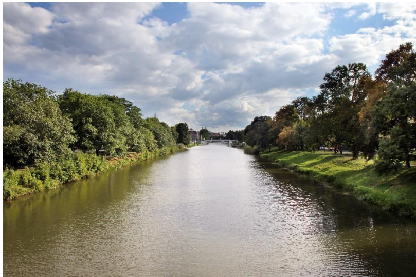
Obrázek 1.2 Pohled na koryto řeky v místě stavby
