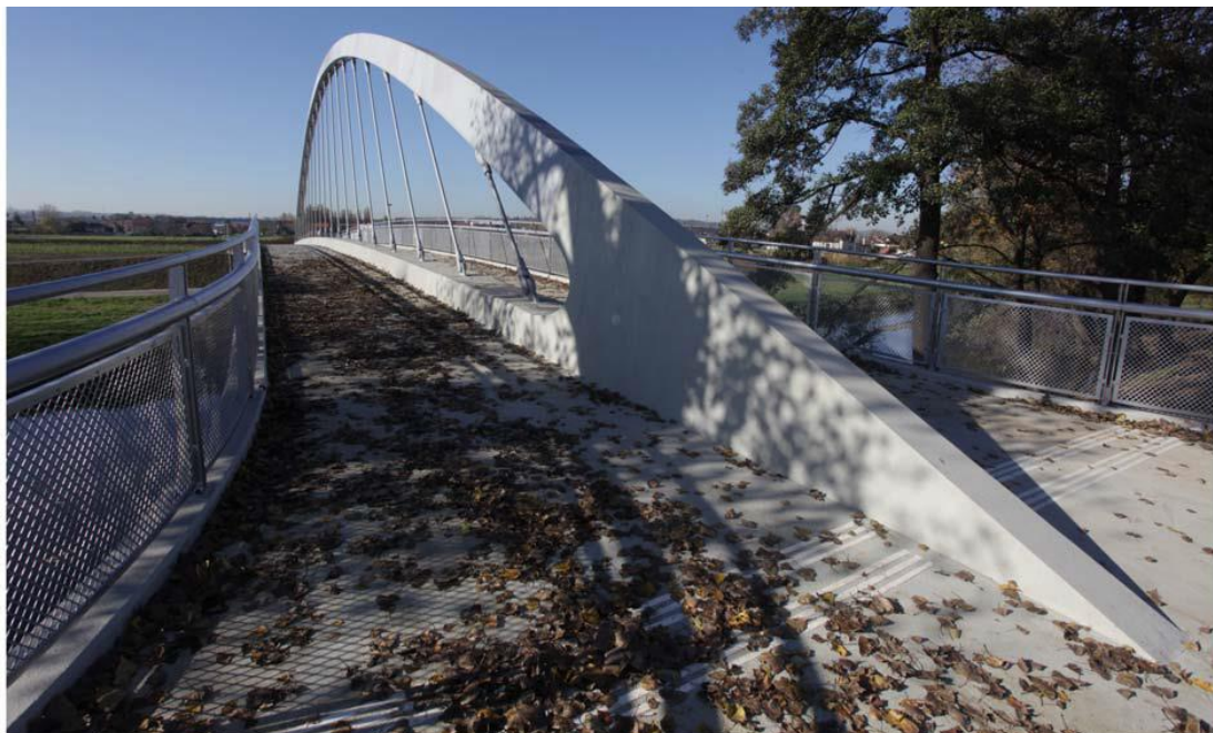
Obrázek 2.8 Oblouková lávka přes Svatku
