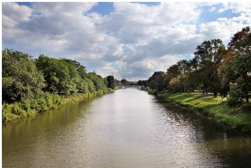
Obrázek 1.2 Pohled na koryto řeky v místě stavby
