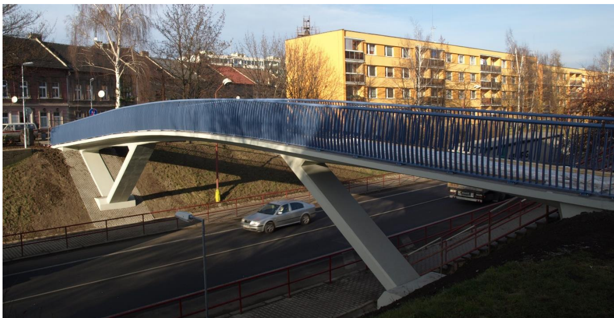
Obrázek 2.9 Lávka ze samozhutnitelného betonu v Lovosicích
