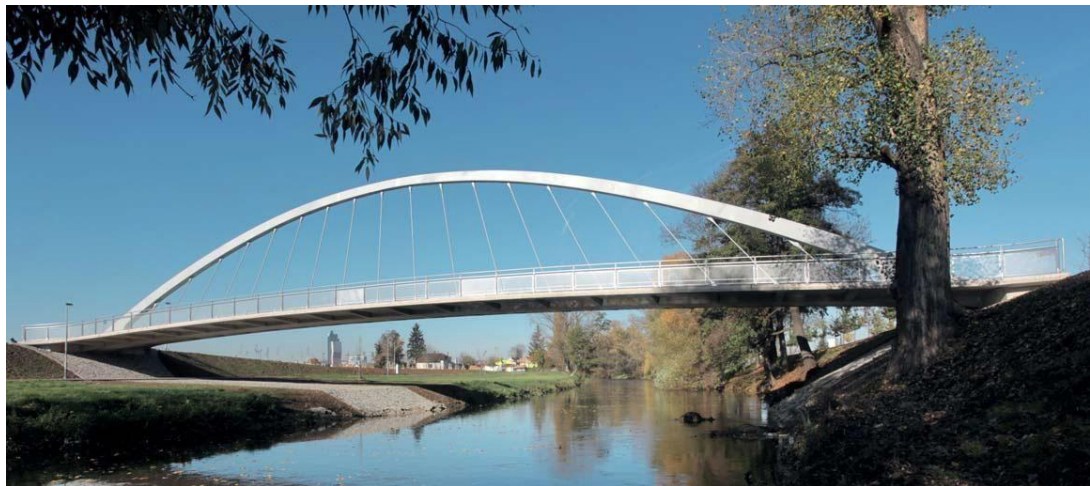
Obrázek 2.7 Oblouková lávka přes Svatku
