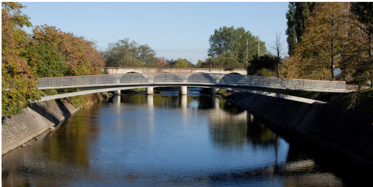
Obrázek 2.1 Lávka přes Svratku, Brno
