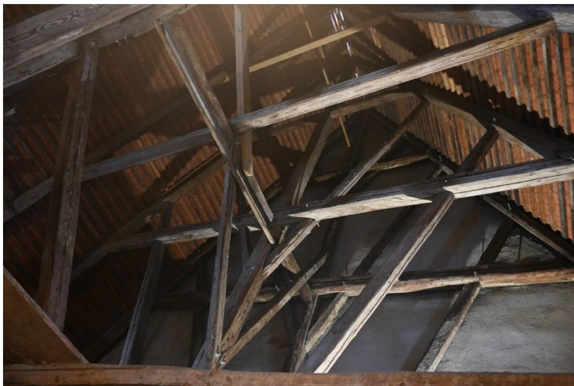
Obr. 17 – 2. až 4. výšková úroveň, úrovně hambalkové
