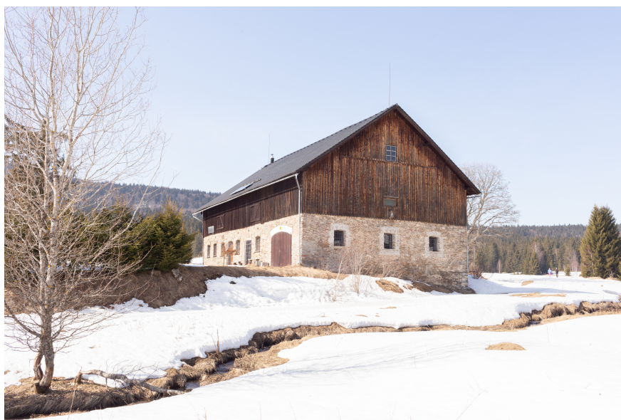
Obrázek 2: Bývalá sklárna v Novém Brunstu (prosinec 2021) Zdroj: Jaromír Harna
