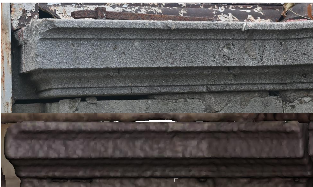
Obr. 40: Detail 4 – fotografie (nahore), model z mračna (dole)
