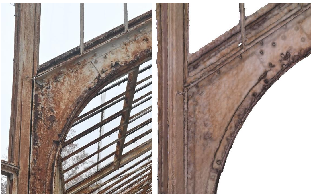
Obr. 38: Detail 2 – fotografie (vlevo), model z mračna (vpravo)
