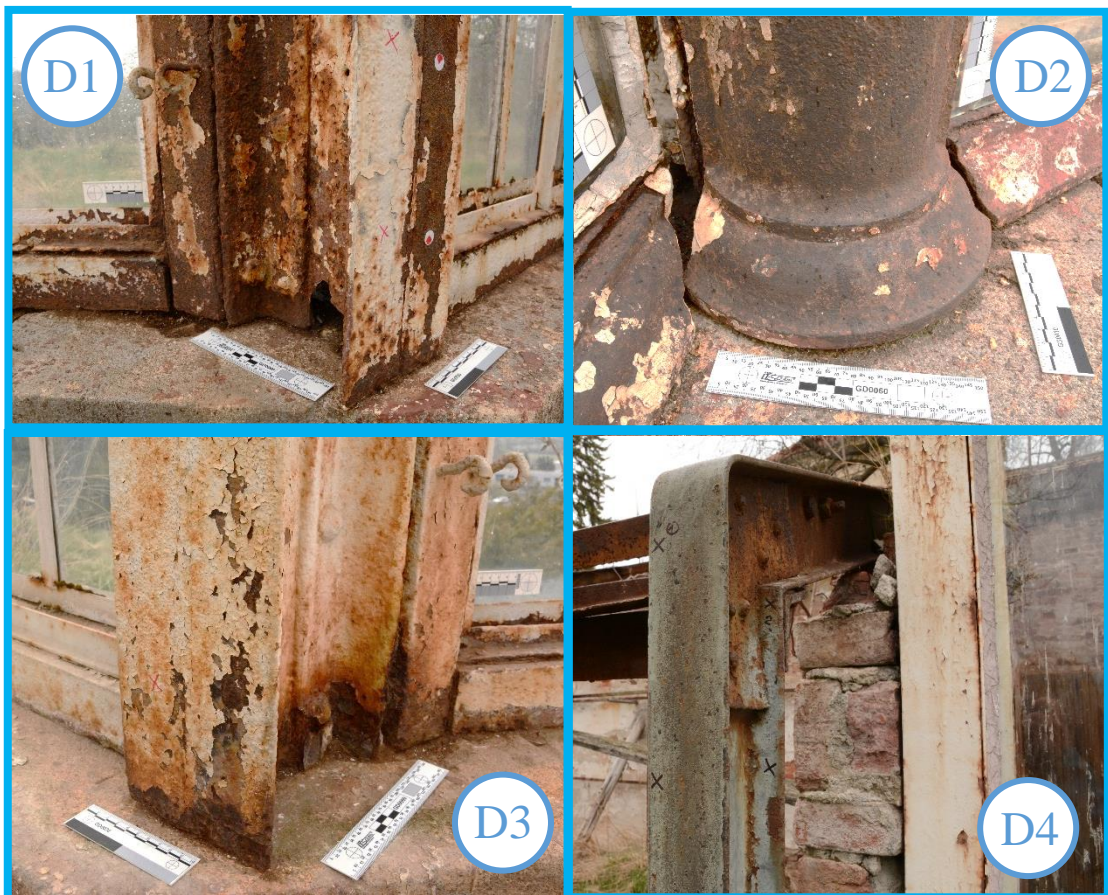
Obr. 18: Nafocené detaily konstrukce - 02
