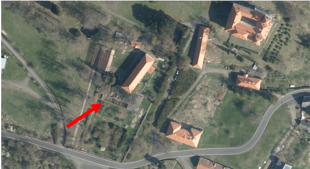
Obr. 4: Objekt skleníku – ortofoto (3)
