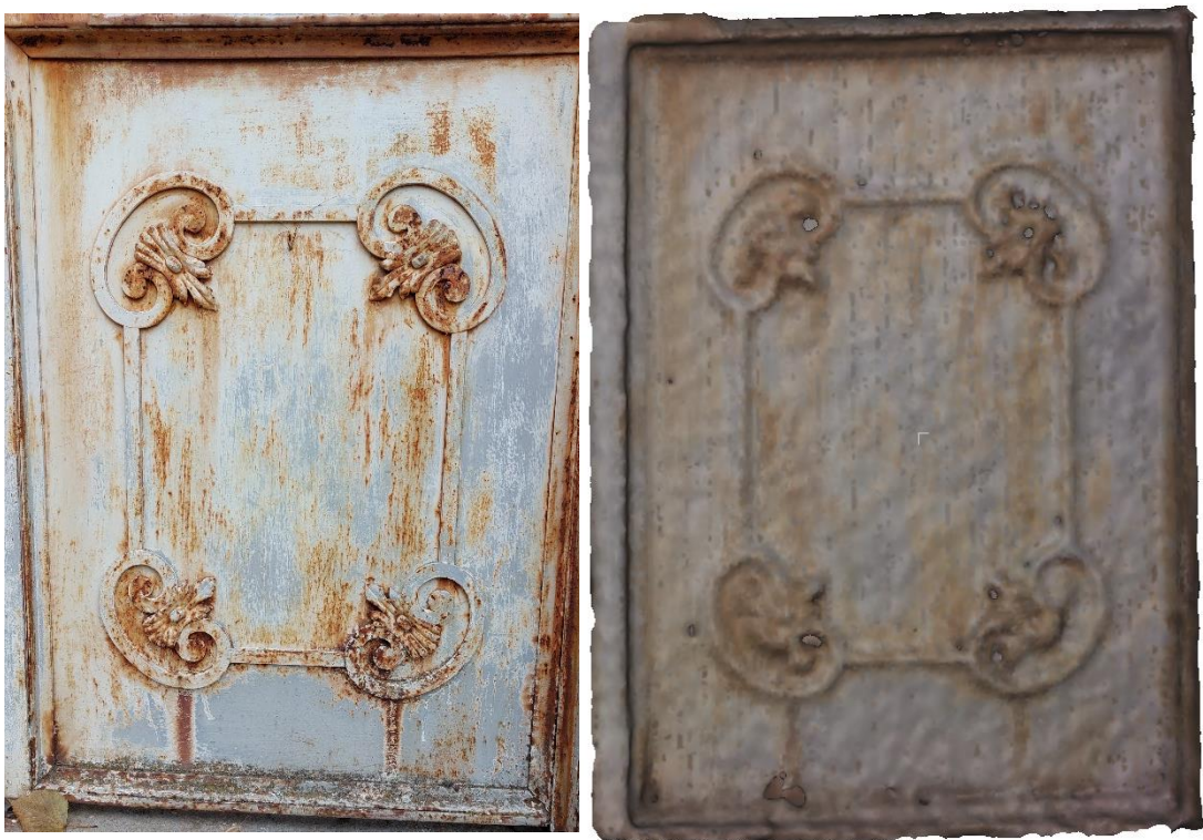
Obr. 37: Detail 1 – fotografie (vlevo), model z mračna (vpravo)
