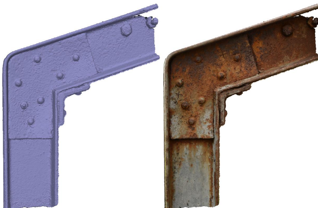
Obr. 51: Model - detail 4 – bez textury (vlevo), s texturou (vpravo)
