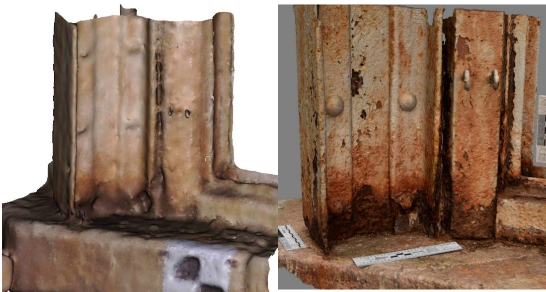
Obr. 56: 3D model – laserové skenování (vlevo), fotogrammetrie (vpravo)
