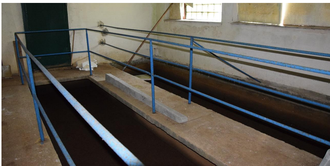
Obr. 29: Pomalé (anglické) otevřené filtry
