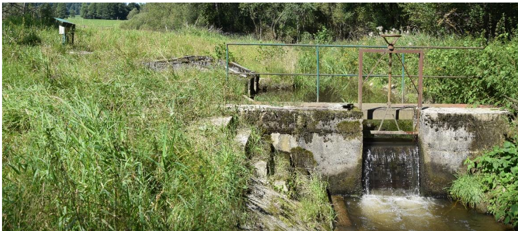
Obr. 26: Břehový jímací objekt a deskové stavidlo
