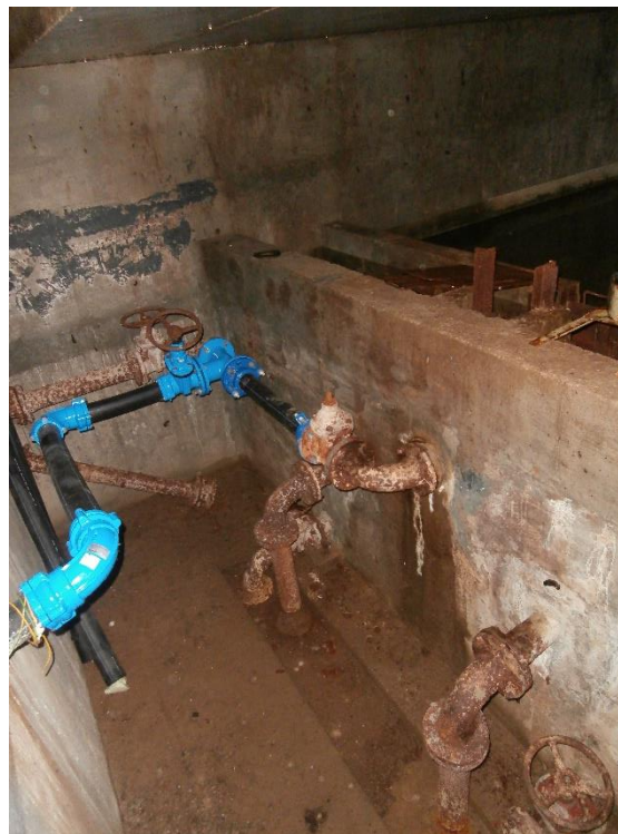
Obr. 25: Vystrojení odkyselovacího filtru
