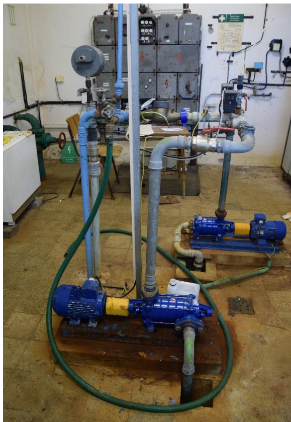
Obr. 30: Vystrojení strojovny na úpravně vody
