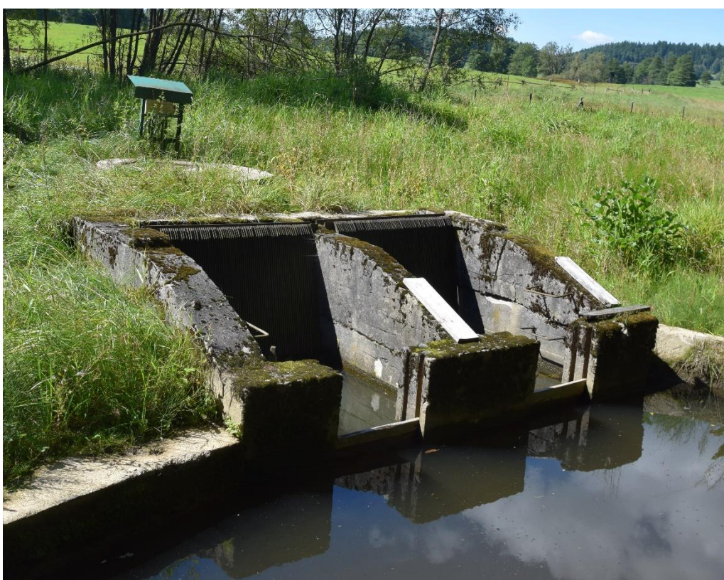
Obr. 27: Dvoukomorový břehový jímací objekt
