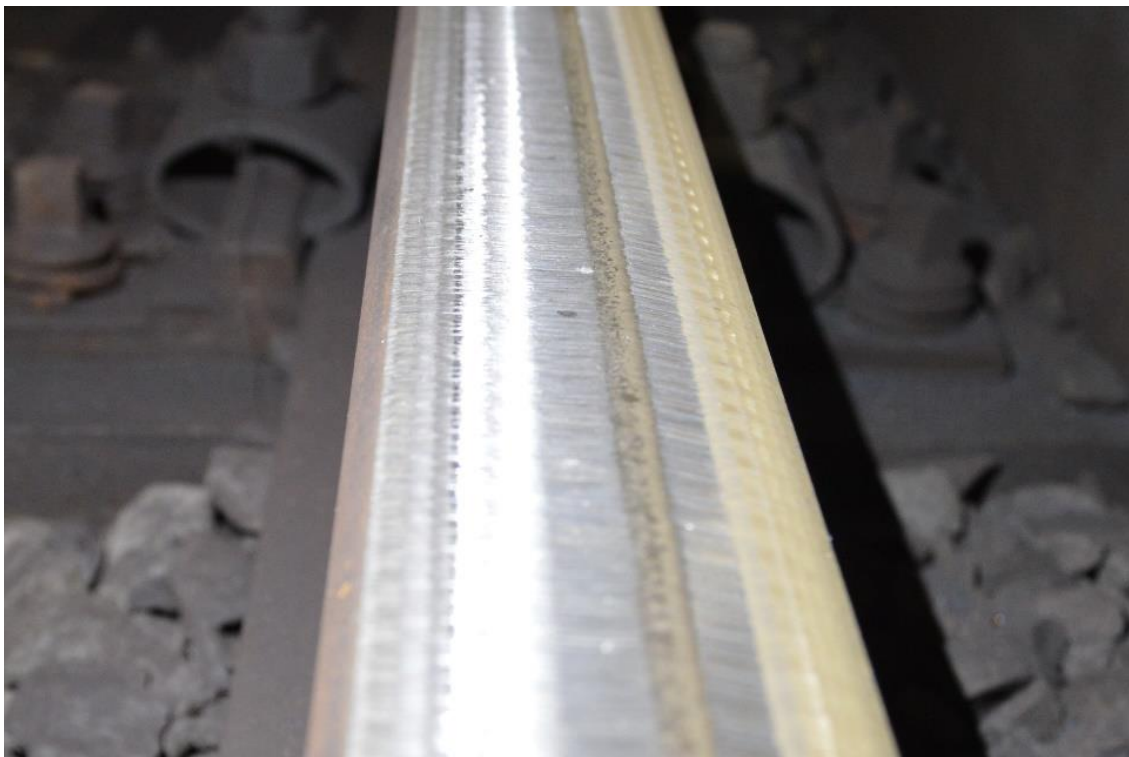
Obr. 16: Detail hlavy kolejnice po úpravě rotačním broušením [Zdroj: Autor]
