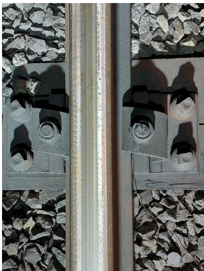
Obr. 22: Detail kolejnice po broušení [Zdroj: Autor]
