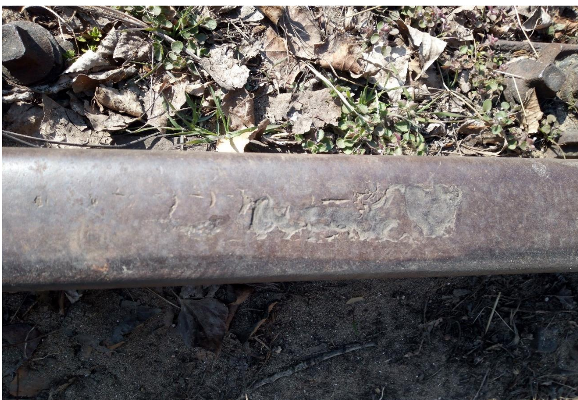
Obr. 1: Miskovitě výlomy, bývalá vlečka přístavu Holešovice [Zdroj: Autor]
