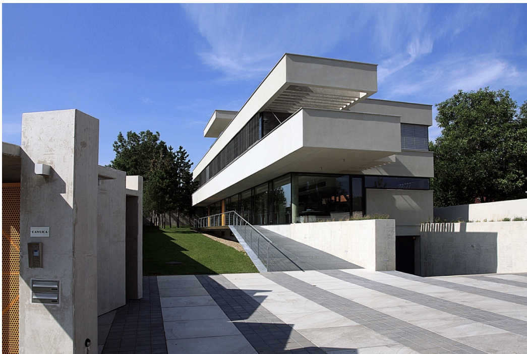
1- Fotografie zadaného objektu [1]
