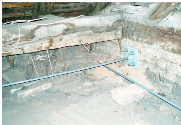
Obrázek 103- stažení stěn táhlem [14]
