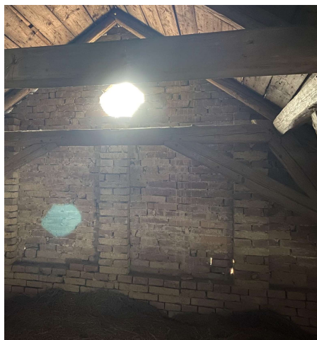
Obrázek 30– krov – zúžení stěny (značení 156)
