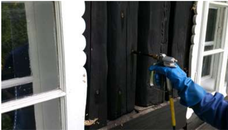
Obrázek 104- provedení vysokotlaké injektáže dřeva [15]
