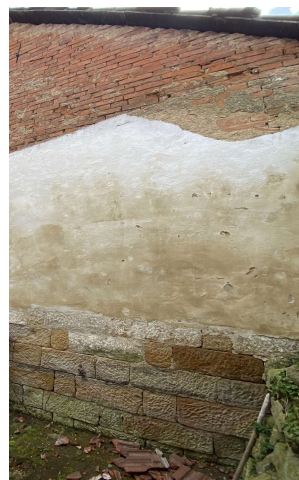
Obrázek 29– severní stěna – složení stěny (značení 140)
