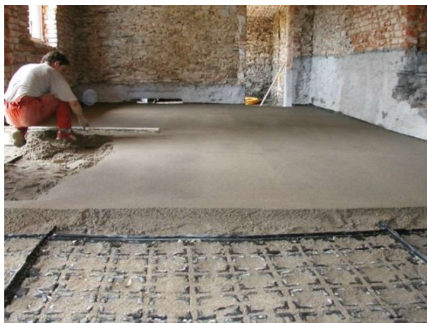
Obrázek 102- provádění provětrávané podlahy IPT systému [10]
