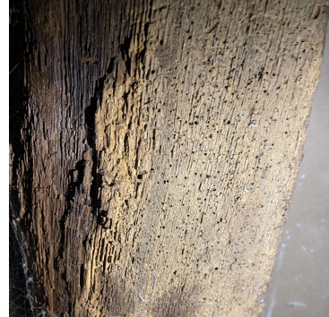
Obrázek 52- chodbička – trám napadený červotočem (značení 45)
