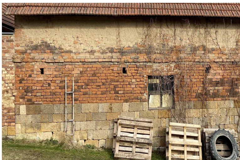
Obrázek 63- opadaná omítka- západ (značení 138)
