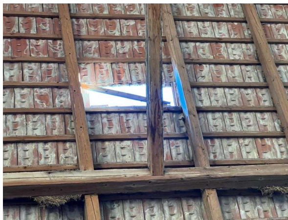
Obrázek 84- lokální trhlina od zatížení (značení č.29) Obrázek 85- lokální trhlina od zatížení (značení č.29)
