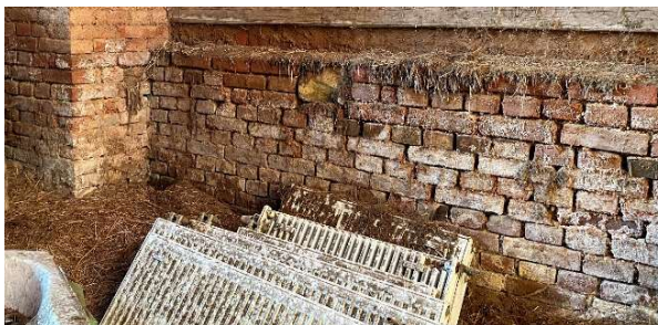
Obrázek 74- růst solí a výkvěty v interiéru (značení č.24)
