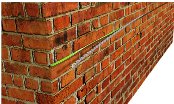
Obrázek 99- vkládání helikální výztuže [6]
