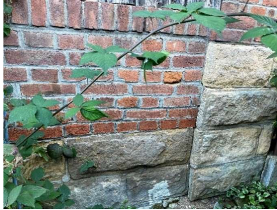
Obrázek 35– základy – východ (značení č.7)
