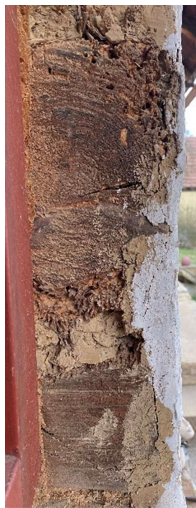
Obrázek 18– koupelna – řez roubenkou
