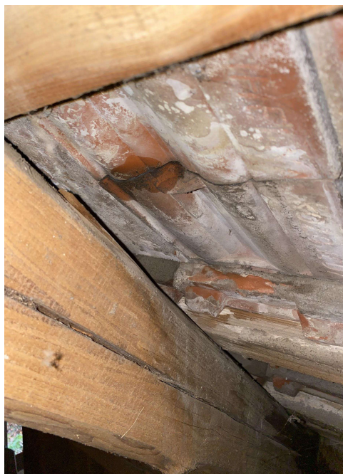
Obrázek 59- Krov – porušení tašek (značení 66)
