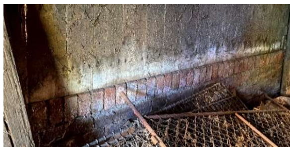
Obrázek 75- růst solí v interiéru (značení č.27)
