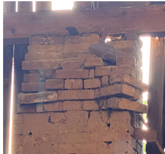
Obrázek 78- vypadané cihly (značení č.33)
