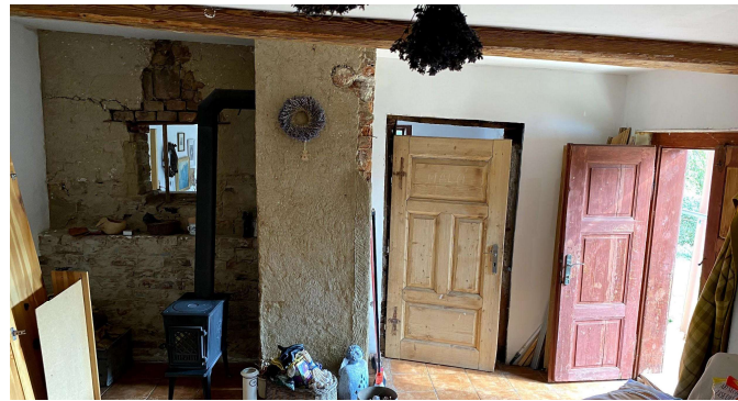
Obrázek 19– předsíň – cihla a sádrokarton (značení 20)
