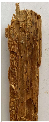
Obrázek 89- dřevo interiér - trám, kuchyně
