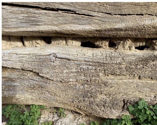
Obrázek 44– ztrouchnivělý trám – západ (značení 132)
