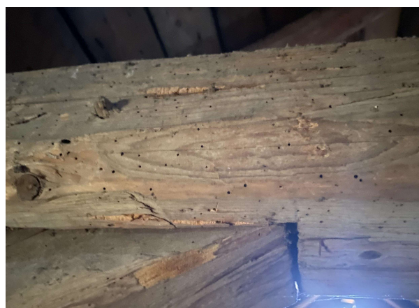
Obrázek 71- kleština napadená červotočem (značení 188)
