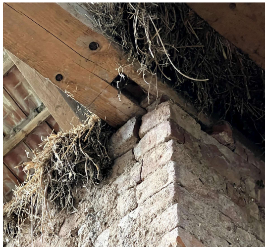
Obrázek 77- lokální trhлина od zatížení (značení č.29)
