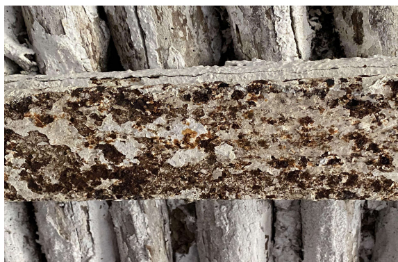
Obrázek 67- rez na ocelovém nosníku (značení 175)
