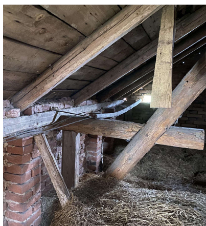
Obrázek 72- napadený krov dřevokazným hmyzem (značení 183)
