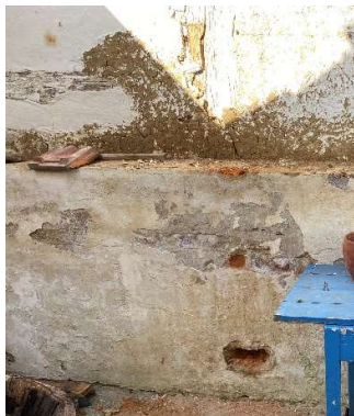
Obrázek 41– vlhkost cihlové podezdívky – jih
