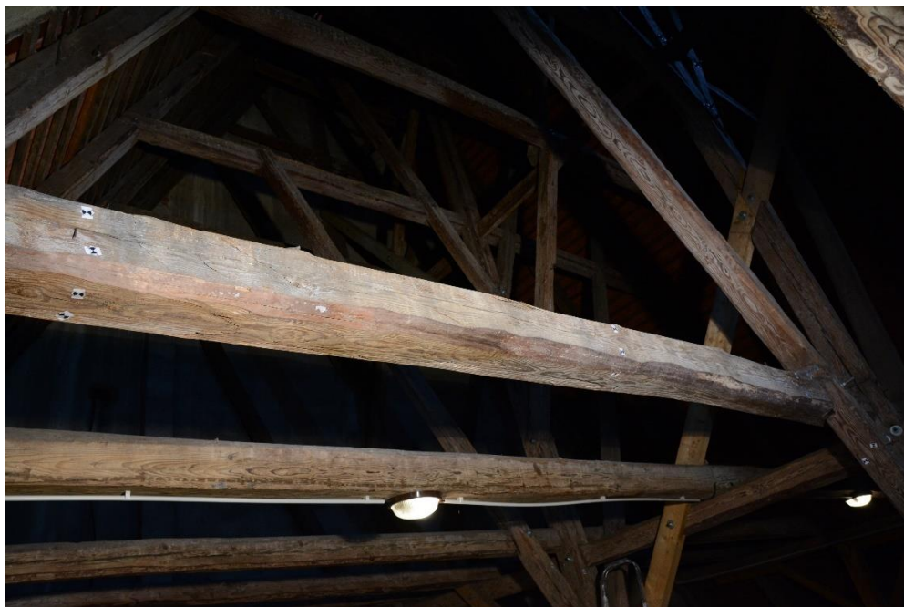
Obr. 20: Snímkování problematického prvku 3 – část hambalku
