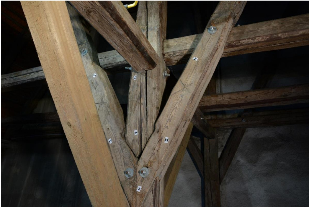
Obr. 22: Snímkování prvku 9 – vzpěry se sloupkem
