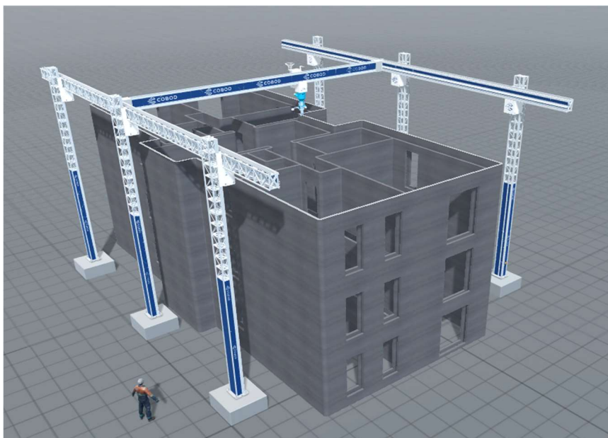
Obrázek 32 Realizace 6 Unit Apartment Block [viz 1]
