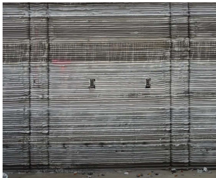
Obrázek 19 Příklad realizované stěny s „U“ záhyby [21]
