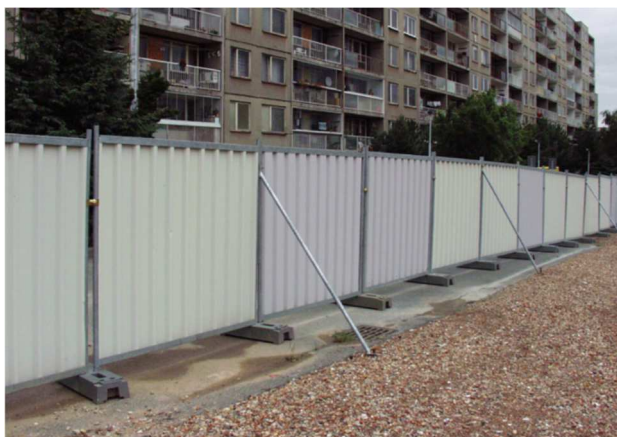
Obr.3: příklad doporučeného plného oplocení staveniště (zdroj: ABS portál; Ing. Kamil Barták, CSc.)
