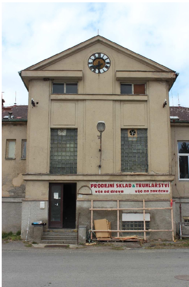
Obrázek 78: Pohled na hlavní věž objektu
