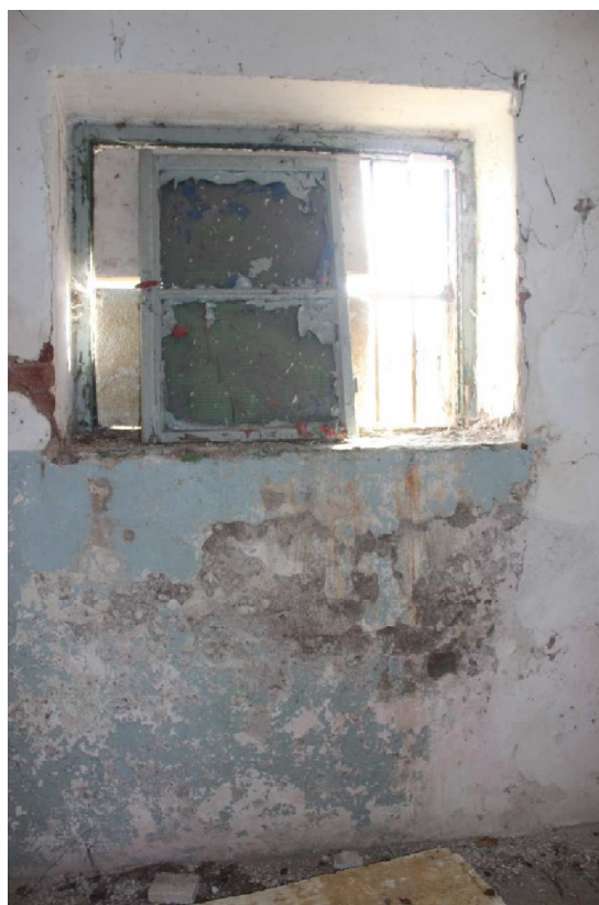
Obrázek 80: Otvory zabedněné polystyrénovými deskami
