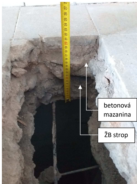
Obrázek 19: Sonda stropu nad 1.PP
