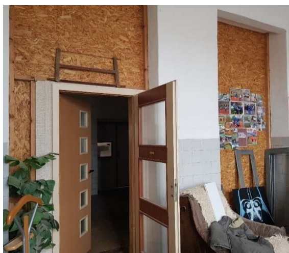
Obrázek 42: Zazděné vnitřní otvory pomocí dřevotřísky
