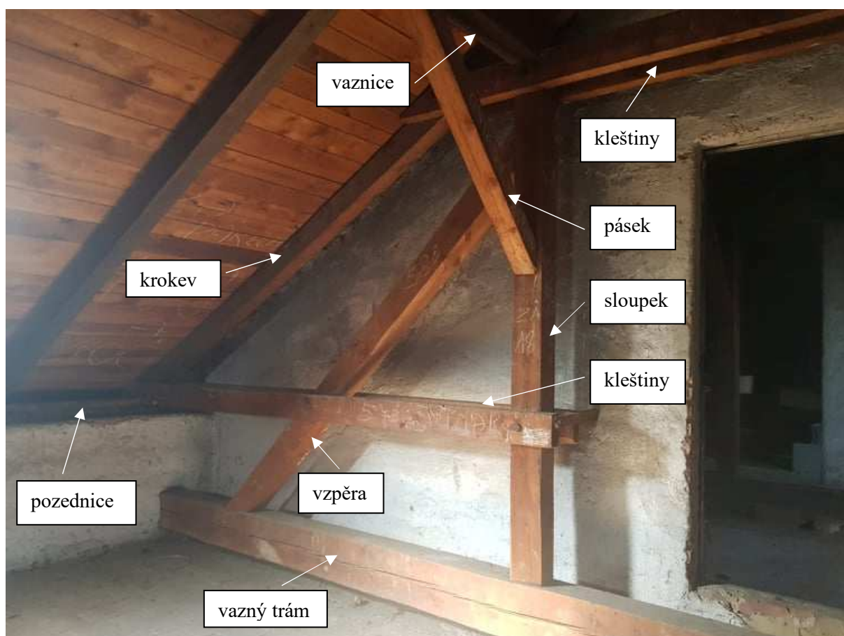
Obrázek 21: Pohled na plnou vazbu krovu
