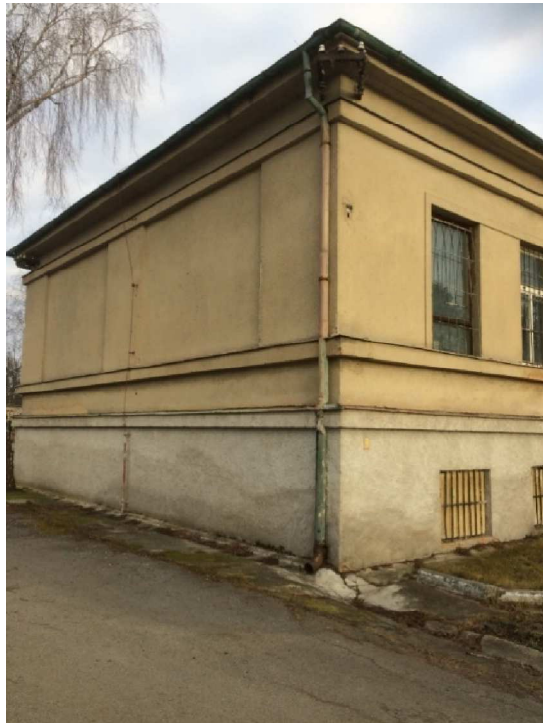
Obrázek 6: Pohled na jižní fasádu objektu
