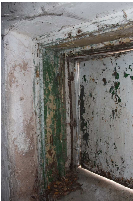
Obrázek 79: Otvory zabedněné plechovými deskami
