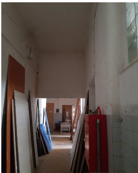
Obrázek 20: Železobetonové monolitické jedním směrem pnuté stropy (strop nad 1.NP)
