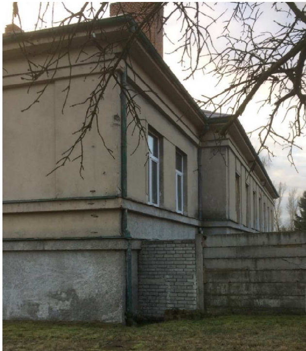
Obrázek 5: Pohled na severní fasádu objektu
