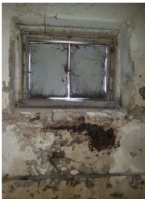
Obrázek 39: Zabetonované suterénní okno
