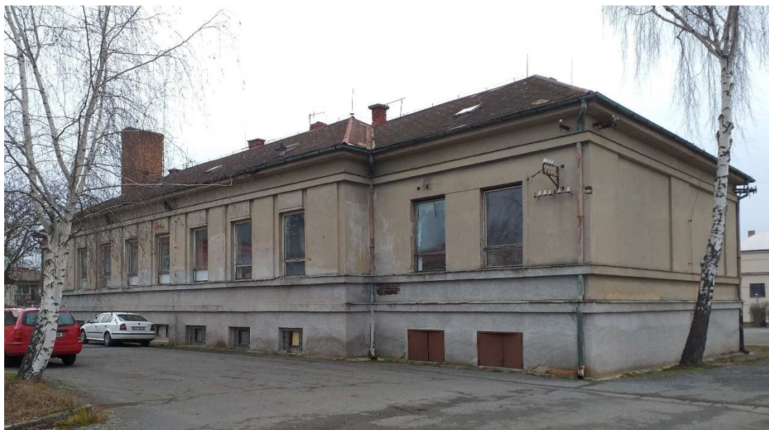
Obrázek 4: Pohled na zadní stranu objektu – západní fasáda
