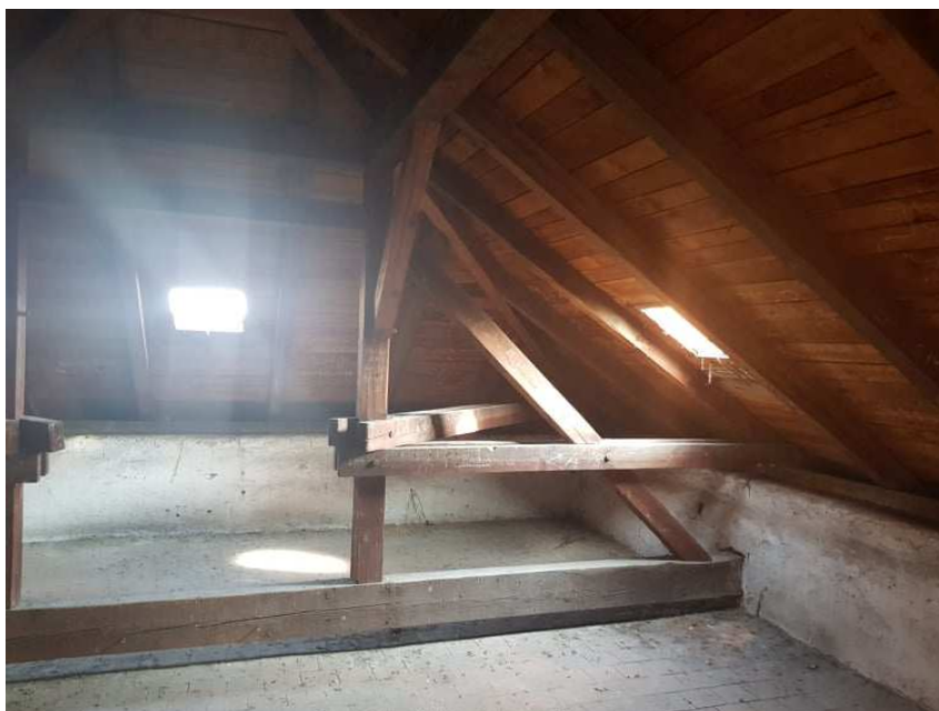
Obrázek 24: Pohled na krovovou konstrukci podepírající valbové ukončení bočního křídla objektu
