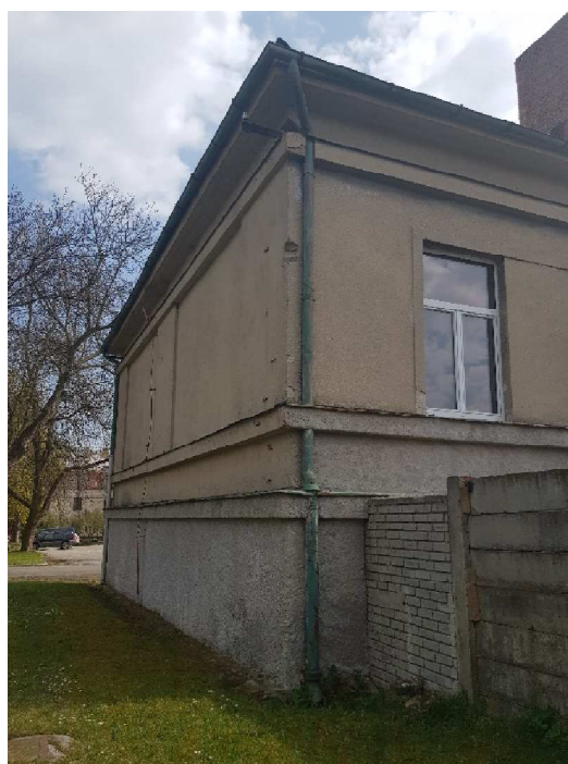
Obrázek 34: Pohled na probíhající římsy a pilastry
