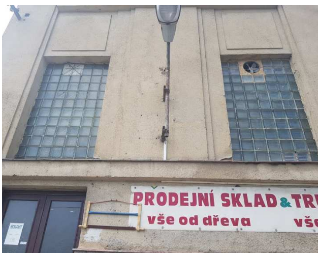
Obrázek 41: Původní okna nahrazená luxferami
