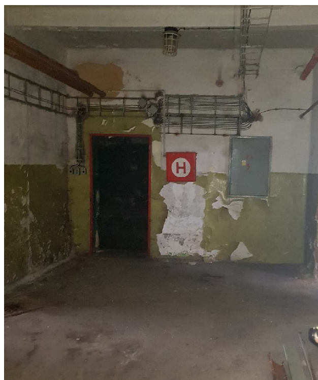
Obrázek 37: Stěny s omyvatelným nátěrem – suterénní chodba
