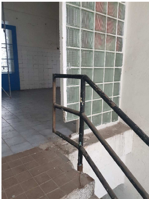
Obrázek 59: Poškozená příčka
