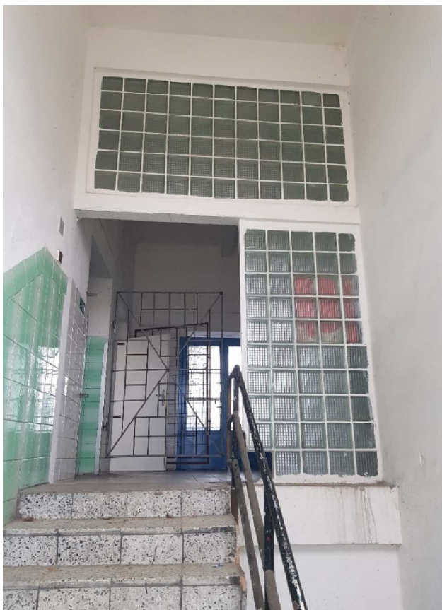
Obrázek 45: Schodiště v jižní části objektu
