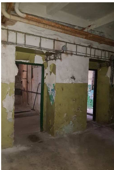
Obrázek 27: Betonová mazanina na podlaze v 1.PP
