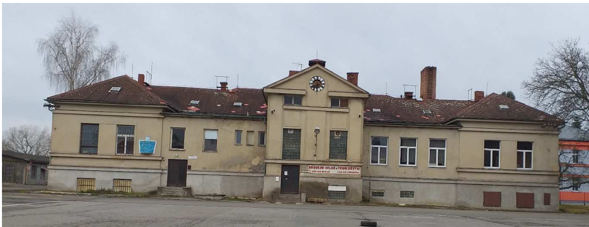
Obrázek 16: Pohled na komínové a odvětrávací tělesa
