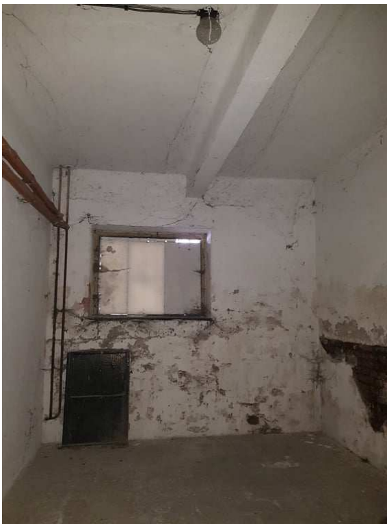
Obrázek 18: Železobetonové monolitické trámové stropy (strop nad 1.PP)
