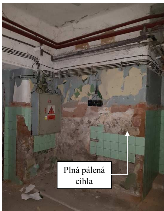
Obrázek 10: Odhalené suterénní zdivo
