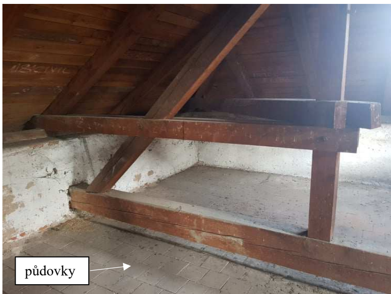
Obrázek 29: Půdovky v půdních prostorech
