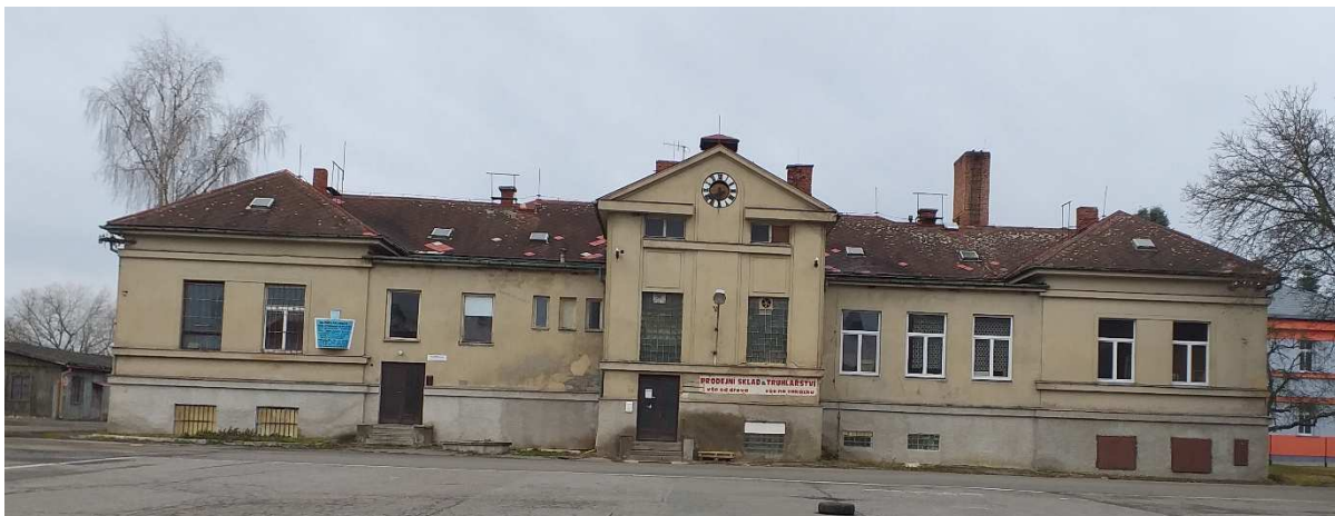
Obrázek 32: Celkový pohled na čelní fasádu
