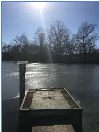
Obrázek 9: Požerák s vodočetnou laťí Obrázek 8: Pohled na spodní výpust
