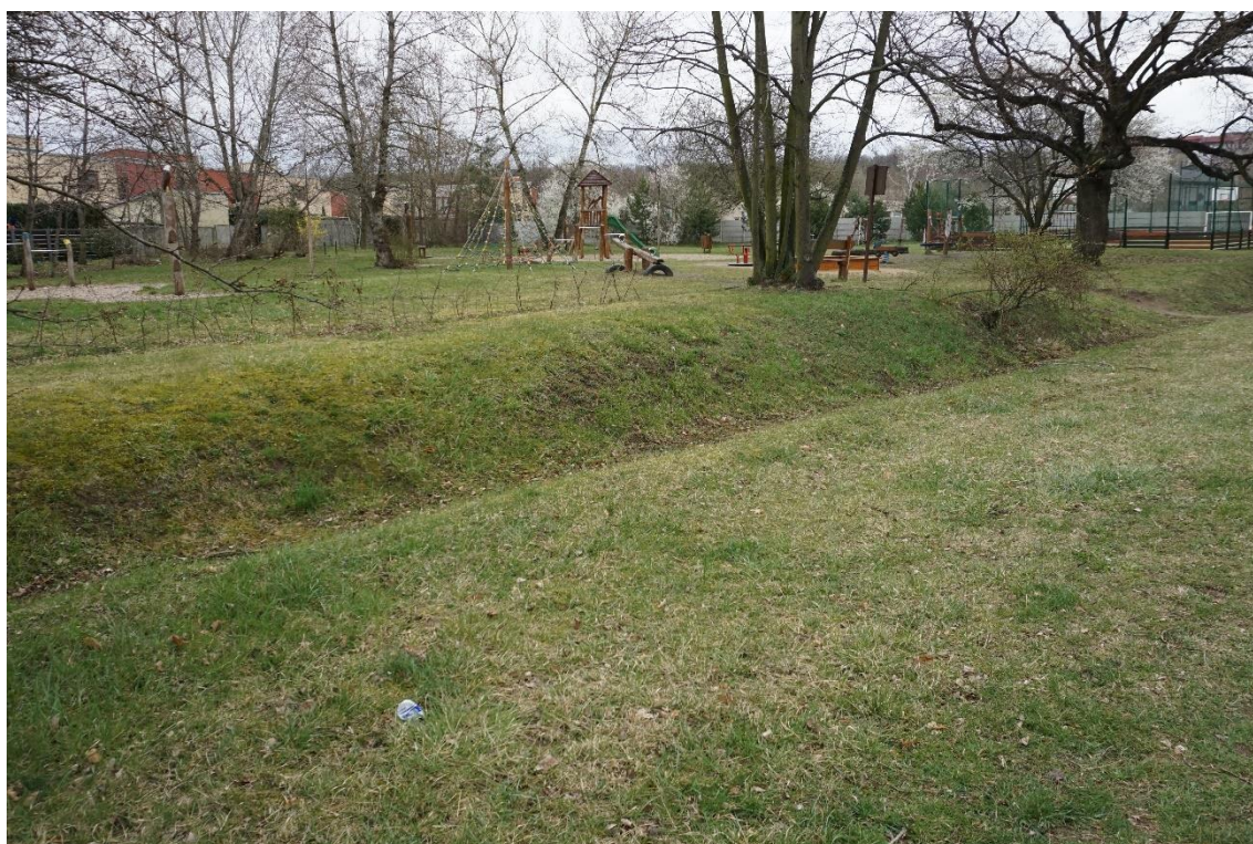
Obrázek 6 – stávající příkop v ulici Sportovní
