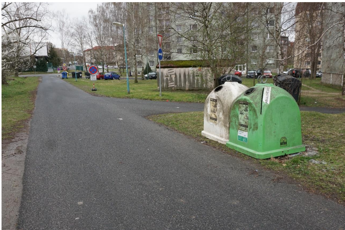
Obrázek 7 – stávající trafostanice v ulici Sportovní, v popředí se nachází nevyhovující plochy pro kontejnery
