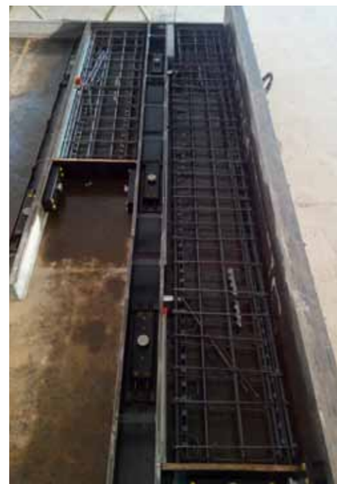
Nachystaná výztuž před betonáží překladů
