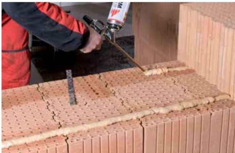
Obr. 6.2: Nanášení zdící pěny
