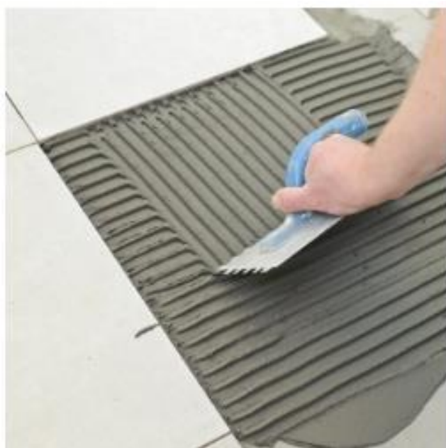
Obr. 6. 3 Nanášení lepidla metodou floating
