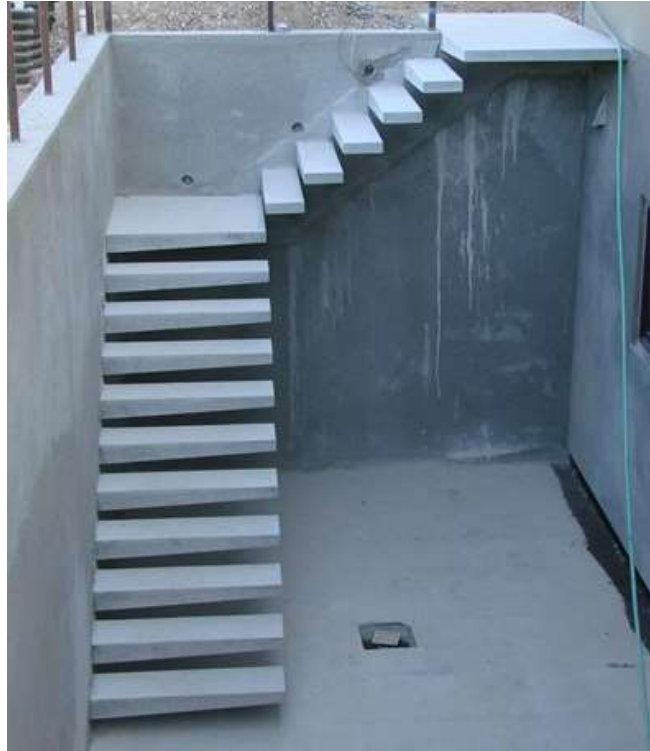
Obrázek 18.: Příklad řešení konzolového schodiště [8]
