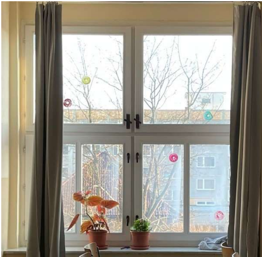
Obr. 90 – Fotografie okna kmenové učebny 6. třídy (pohled z interiéru)
