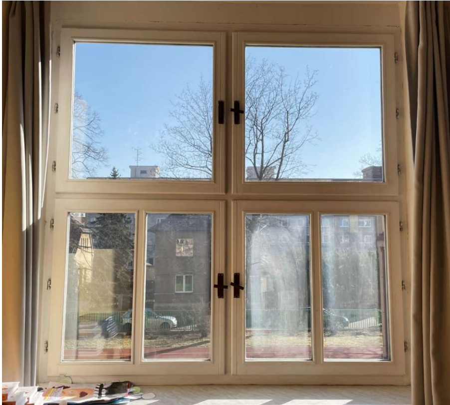
Obr. 67 – Fotografie okna kmenové učebny 5. třídy (pohled z interiéru)
