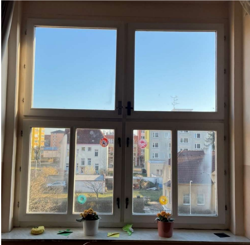
Obr. 102 – Fotografie okna kmenové učebny 9. třídy (pohled z interiéru)
