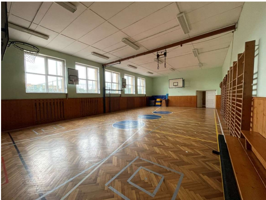
Obr. 38 – Fotografie interiéru tělocvičny (pohled směrem na vstupní dveře)
