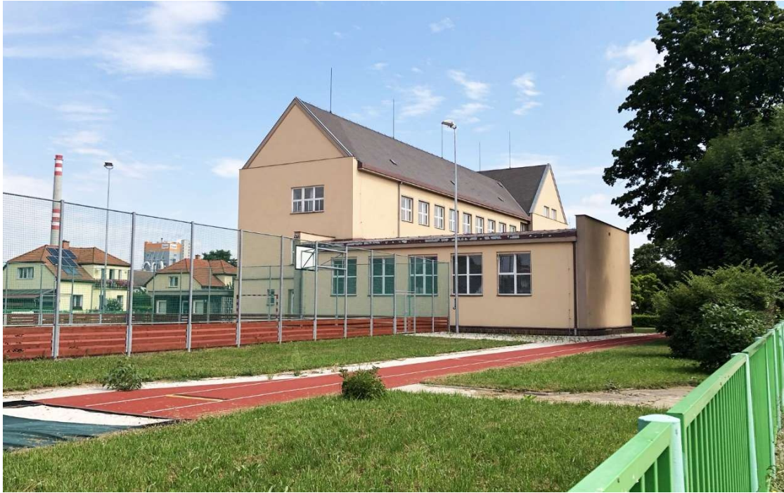
Obr. 123 – Venkovní pohled na tělocvičnu
