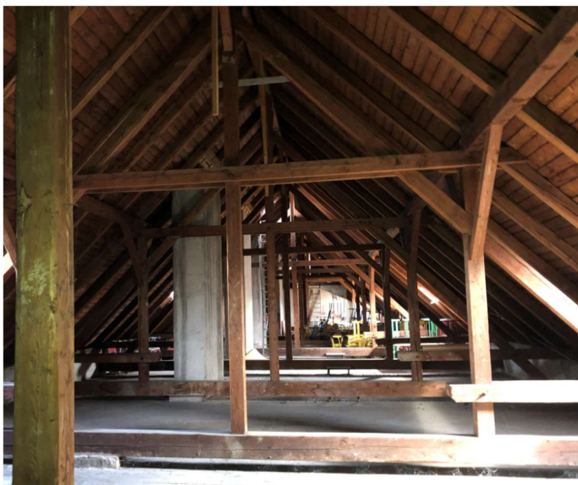
Obr. 13 – Fotografie krovu budovy školy, trojitě věšadlo
