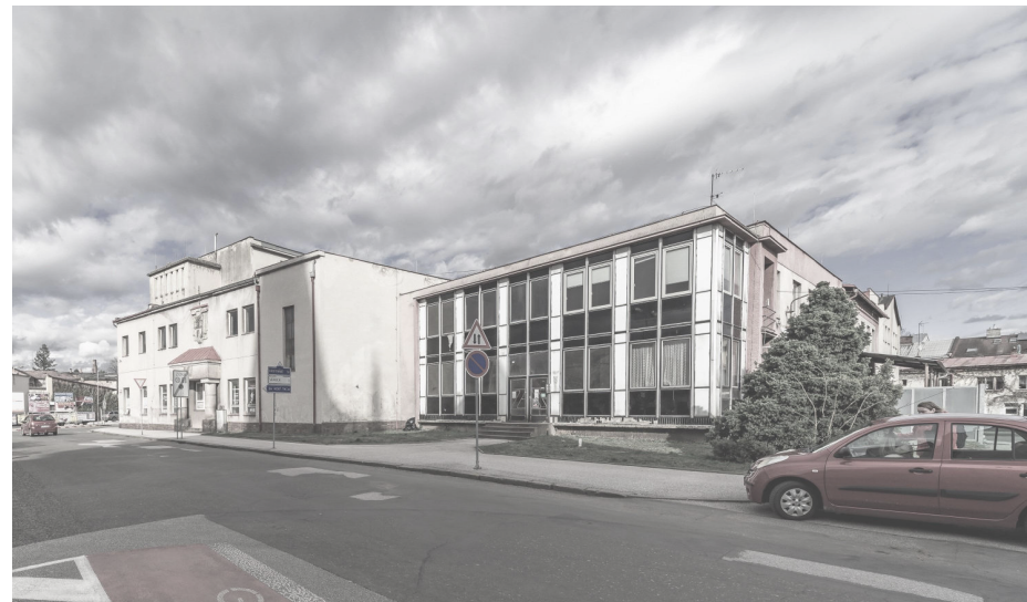
Mayerova továrna_stávající stav
