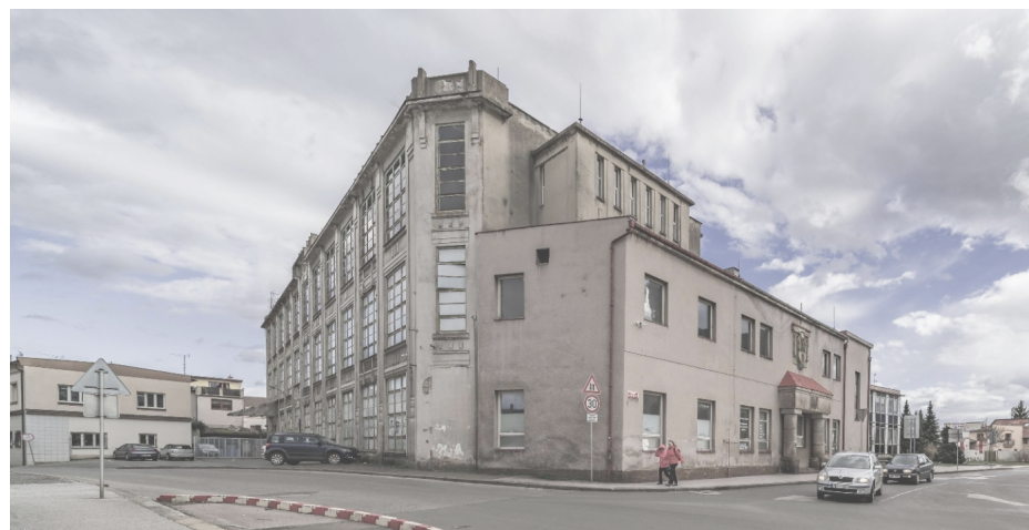
Mayerova továrna_stávající stav
