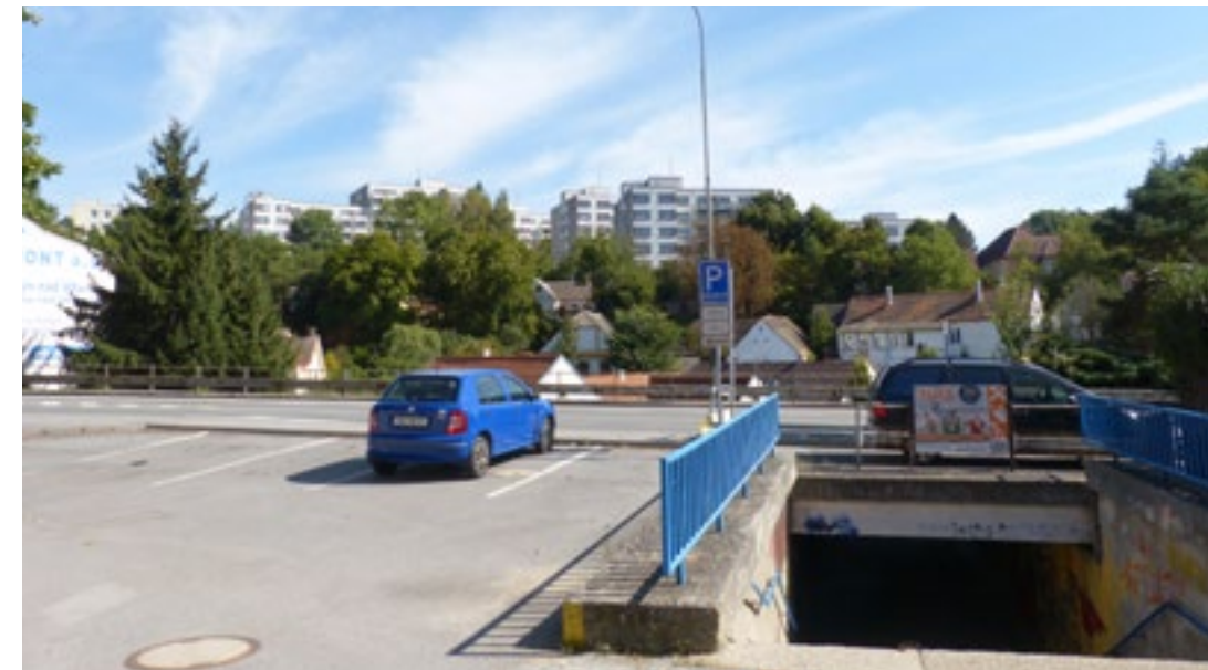
Peklo s hradbou sídliště Hlinka a bývalou ubytovnou Blanice. Přístupné podchodem. (Zdroj: archiv autorky)
