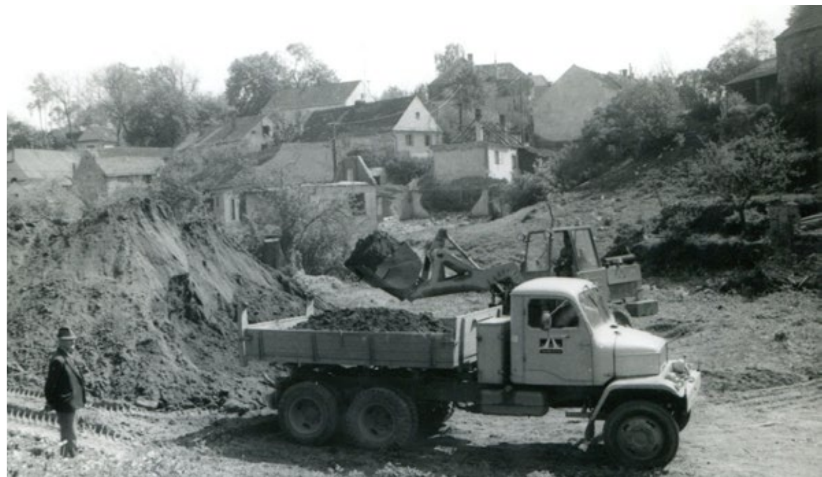
Demolice domů překážejících novému dopravnímu spojení na Tábor, 80. léta (Zdroj: https://www.starytyn.cz/fotogalerie/demolice-behem-stavby-silnice-na-tabor/ )
