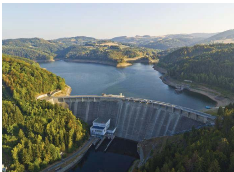
Obrázek 7. Betonová tízná přehrada [11]
