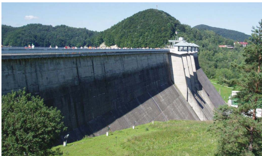
Obrázek 8. Betonová tížná přehrada [14]
