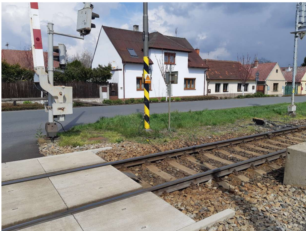
Obr.15 – Umístění výstražníku, konec přejezdu
