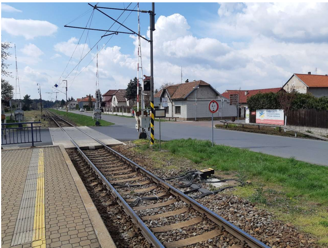
Obr.13 – Pohled na železniční přejezd z nástupiště
