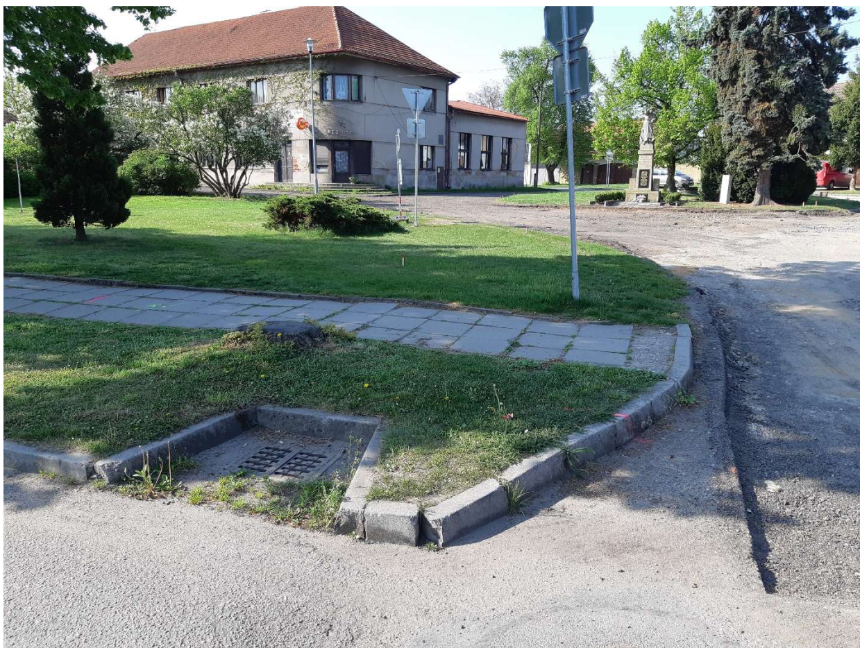
Obr.8 – Detail špatného zaoblení obruby
