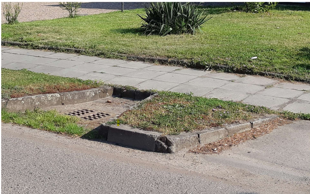
Obr.7 – Detail poškození obruby
