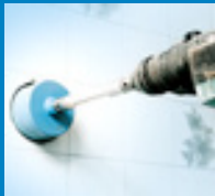
Vyvrtejte otvor do stěny
