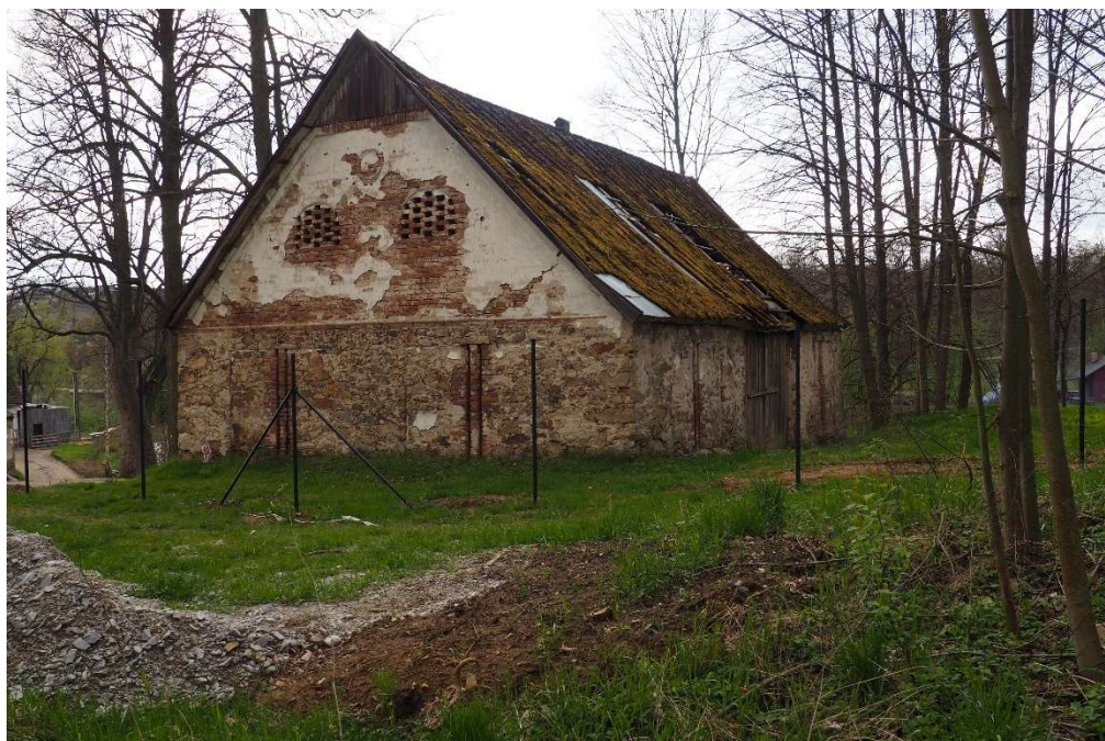
Obr.2 Východní pohled (současný stav)
