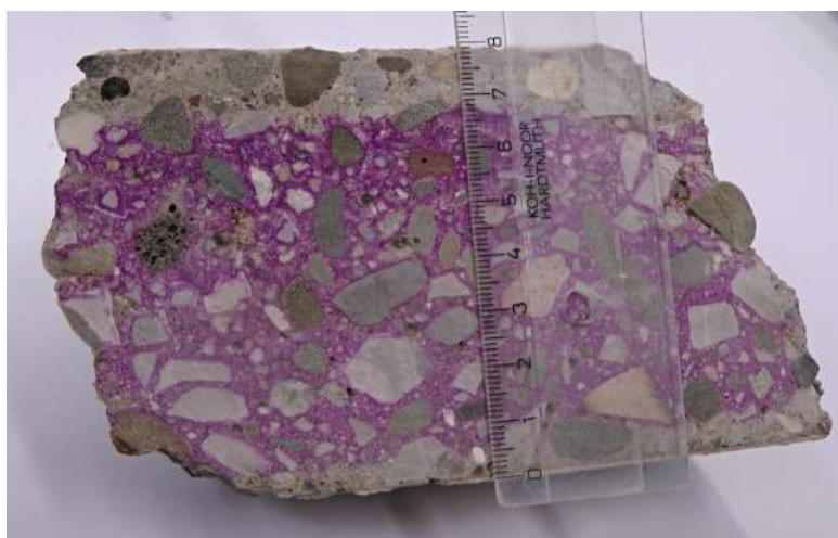
Obr. 2 - Měření mocnosti zkarbonatované vrstvy [21]
