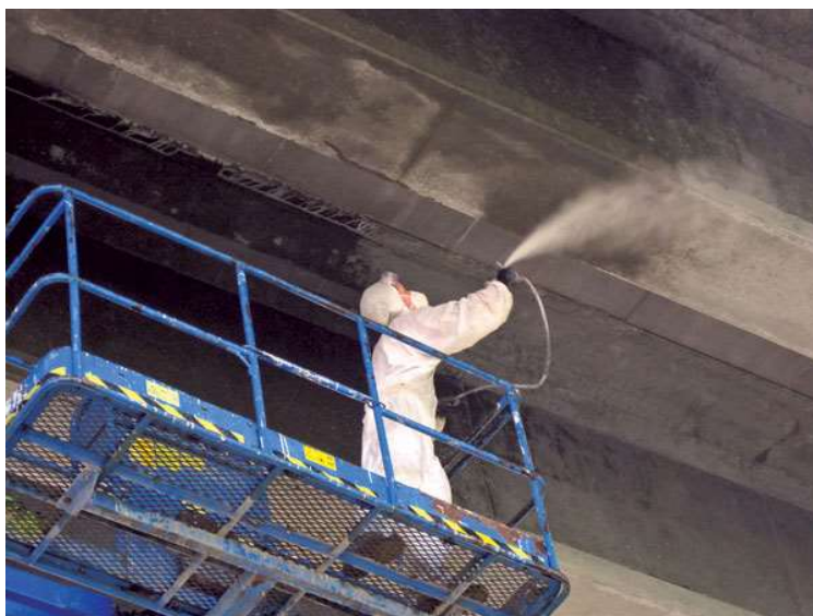
Obr. 12 - Provádění impregnace mostu ve Vchynici [17]
