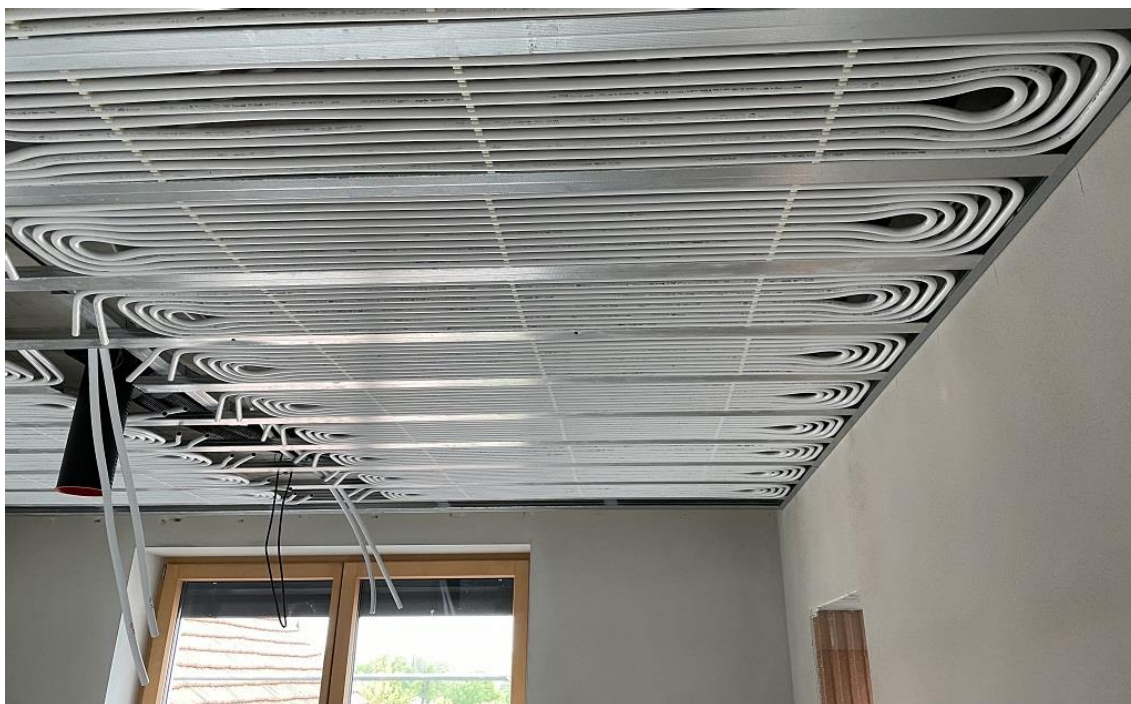
Obr. 22: Sálavé stropní vytápění [25]
