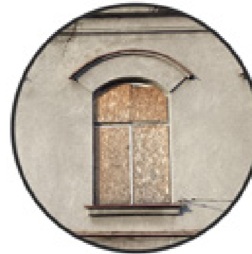
chybějící výplně
