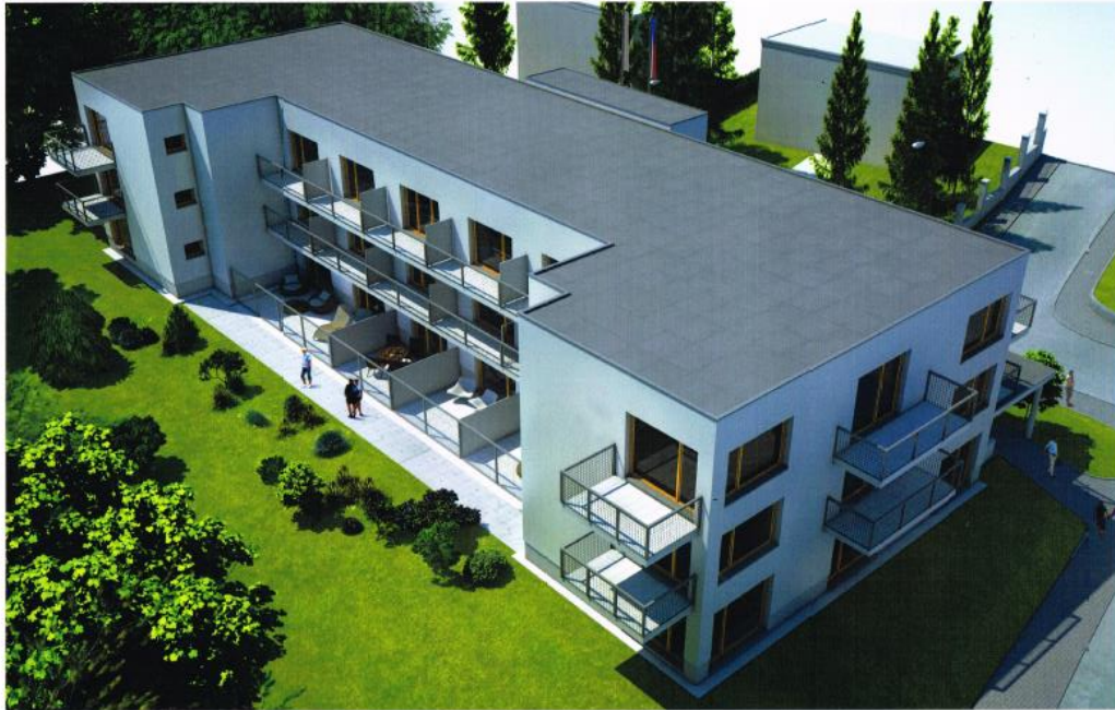
Obrázek 18: Pohled na střech objektu [18]
