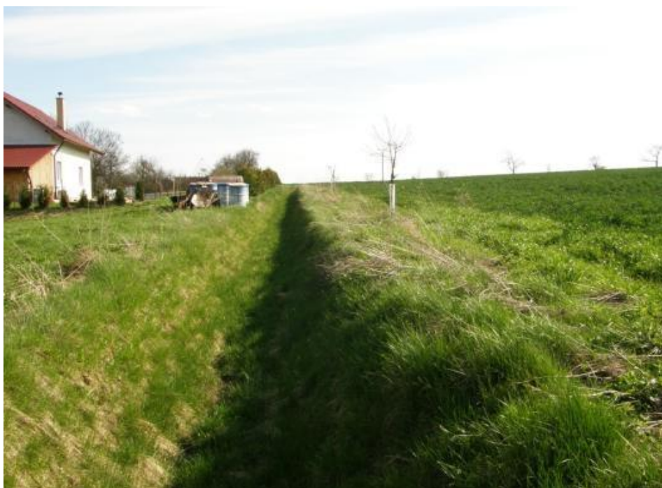
Obrázek 7 - Protierozní záchytný příkop-obec Rašovice u Uhlířských Janovic (VÚMOP-Výzkumný ústav meliorací a ochrany půd)
