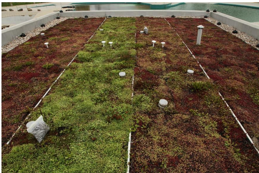
Obrázek 14: Zelená střecha na budově pokladny koupaliště Malviny
