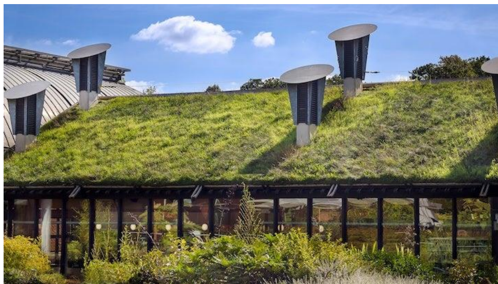
Obrázek 2: Extenzivní zelená střecha (převzato z Clissitt, 2022)
