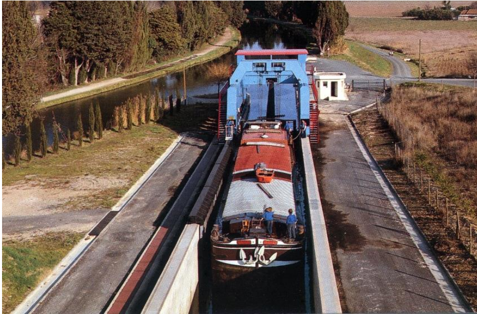
Obrázek 6. Lodní výtah, Fonserannes, Francie [9]
