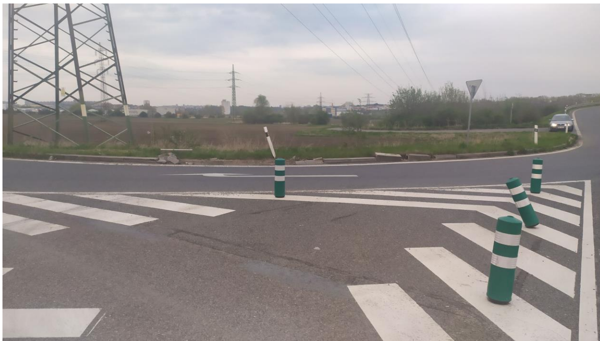
Obrázek 37 - Foto zničené obruby na okraji křižovatky
