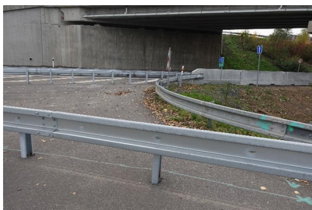
Obrázek 70 – Pohled na původní ocelová svodidla v hrotu křižovatky.
