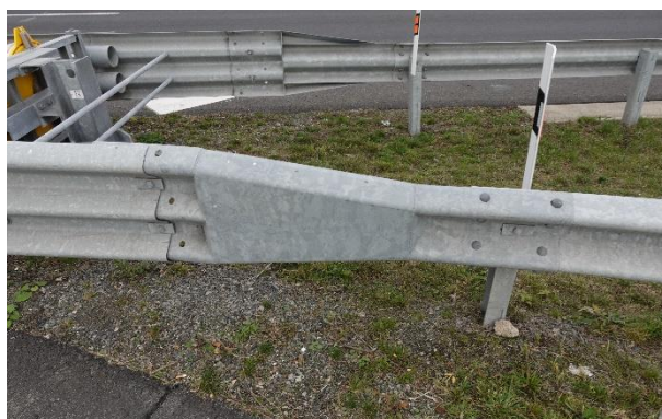
Obrázek 16 – Boční detailní pohled na řešení tlumiče nárazu.
