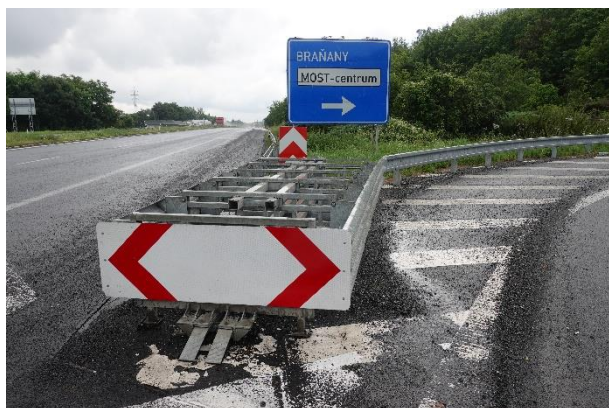
Obrázek 86 – Pohled na sledovanou lokalitu ve směru staničení silnice I/13.
