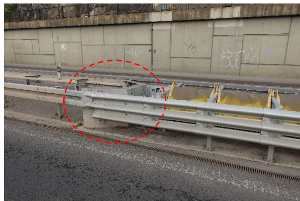
Obrázek 148 – Pohled na koncovou část původního tlumiče nárazu, který zde byl dříve umístěn.
