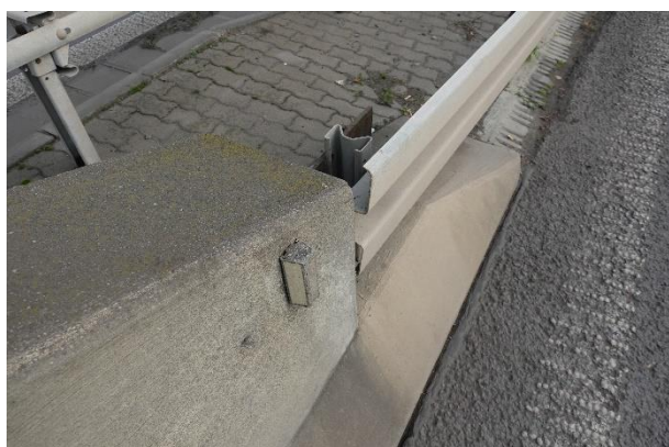
Obrázek 149 – Pohled na napojení ocelového svodidla na betonovou zeď.
