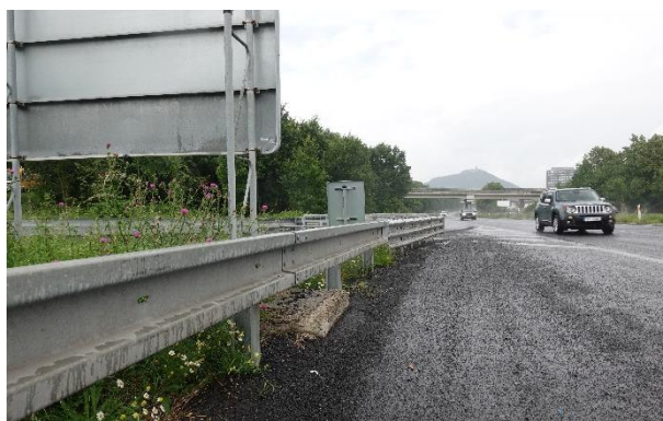
Obrázek 89 – Vyčnívající betonový základ SDZ v blízkosti hlavní silnice.
