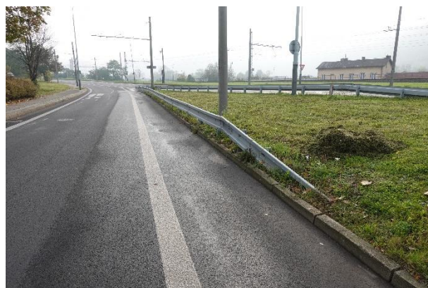
Obrázek 158 – Pohled na konec ocelových svodidel ve větví MÚK.
