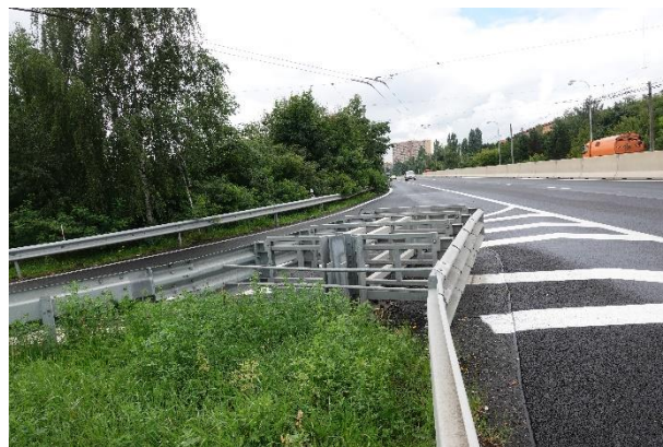
Obrázek 40 – Výhled z místa tlumiče nárazu ve směru proti příjezdu dopravního proudu.
