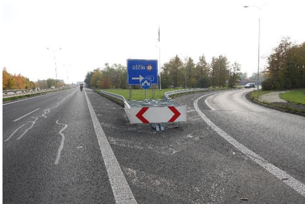
Obrázek 103 – Pohled na sledovanou lokalitu ve směru proti staničení silnice I/8.
