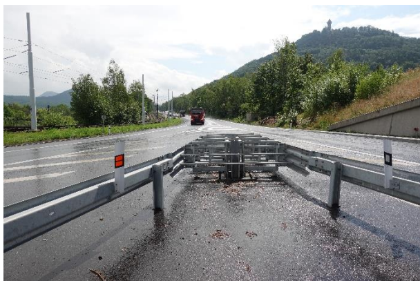
Obrázek 68 – Výhled z místa tlumiče nárazu ve směru proti příjezdu dopravního proudu.
