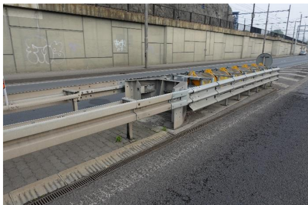
Obrázek 147 – Ukázka zakončení tlumiče nárazu a jeho napojení na ocelová svodidla.
