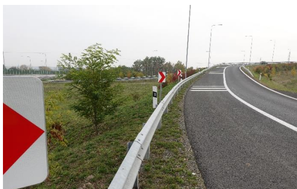
Obrázek 18 – Ukázka navazujících ocelových svodidel a dopravního zařízení Z 3 podél větve MÚK.
