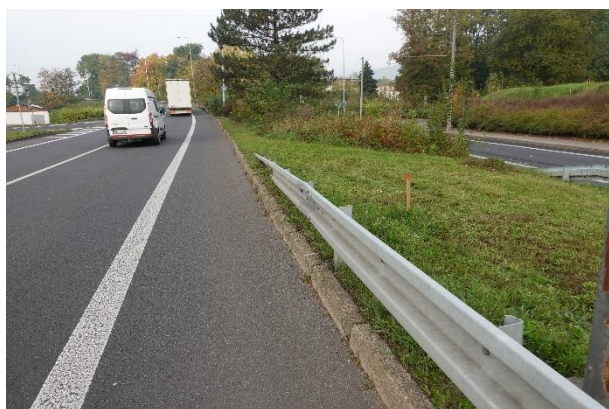
Obrázek 157 – Pohled na zakončení ocelových svodidel na hlavní PK.
