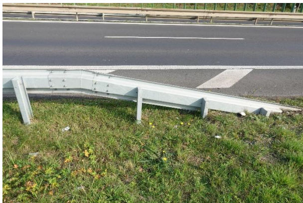
Obrázek 117 – Pohled na zakončení ocelových svodidel na hlavní PK.
