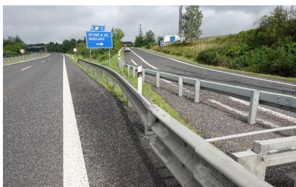
Obrázek 133 – Boční pohled na ocelová svodidla v dopravním ostrůvku MÚK ze SMV I/63.
