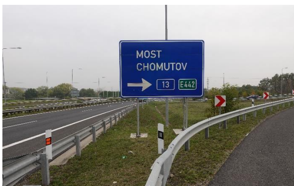
Obrázek 17 – Pohled na polohu SDZ IS 7a a sloup VO, které se nacházejí v místě dopravního ostrůvku.
