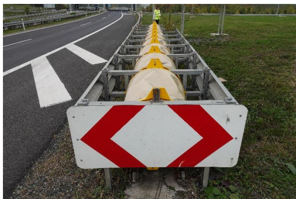
Obrázek 6 – Detailní pohled na řešený tlumič nárazu ve směru staničení silnice I/7.
