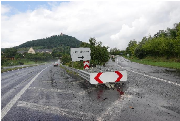
Obrázek 76 – Pohled na sledovanou lokalitu ve směru proti staničení silnice I/13.
