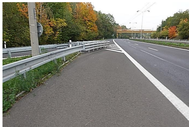
Obrázek 31 – Výhled z místa tlumiče nárazu ve směru proti příjezdu dopravního proudu.
