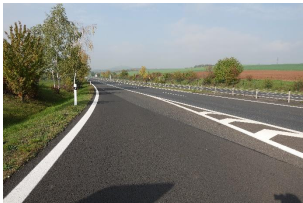
Obrázek 122 – Výhled z místa tlumiče nárazu ve směru proti příjezdu dopravního proudu.
