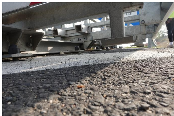
Obrázek 116 – Mezera mezi vozovkou a tlumičem nárazu.
