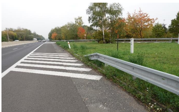
Obrázek 43 – Ukázka zakončení ocelového svodidla na hlavní PK.
