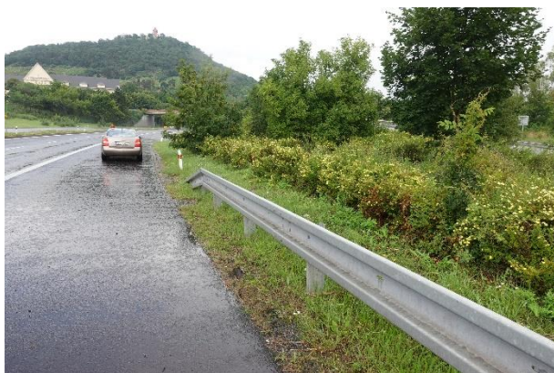
Obrázek 82 – Pohled na zakončení ocelových svodidel na hlavní PK.
