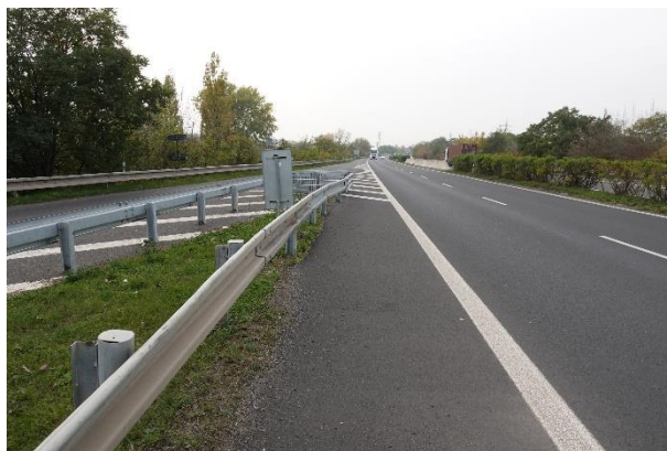
Obrázek 58 – Výhled z místa tlumiče nárazu ve směru proti příjezdu dopravního proudu.
