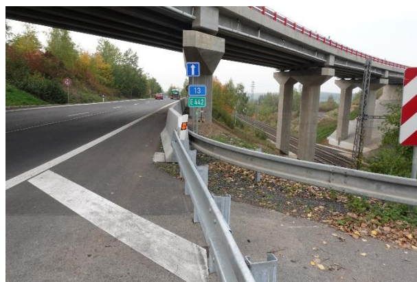
Obrázek 71 – Ukázka napojení ocelového svodidla na betonové svodidlo.
