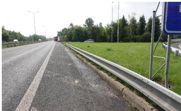
Obrázek 108 – Pohled na zakončení ocelových svodidel napojených na tlumič nárazu.
