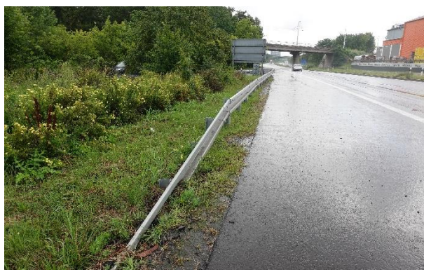
Obrázek 91 – Pohled na zakončení ocelových svodidel napojených na tlumič nárazu.
