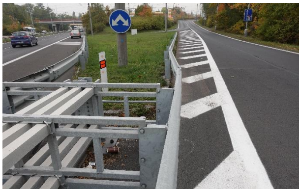
Obrázek 32 – Ukázka pevné překážky (sloup trakčního vedení) v místě dopravního ostrůvku.
