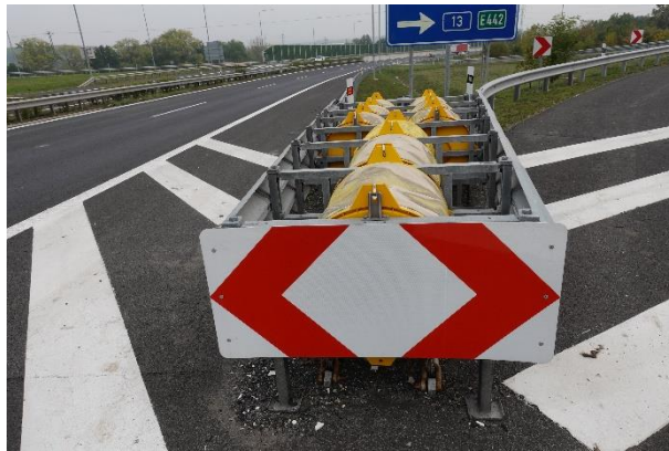
Obrázek 14 – Detailní pohled na řešení tlumiče nárazu ve směru příjezdu dopravního proudu.
