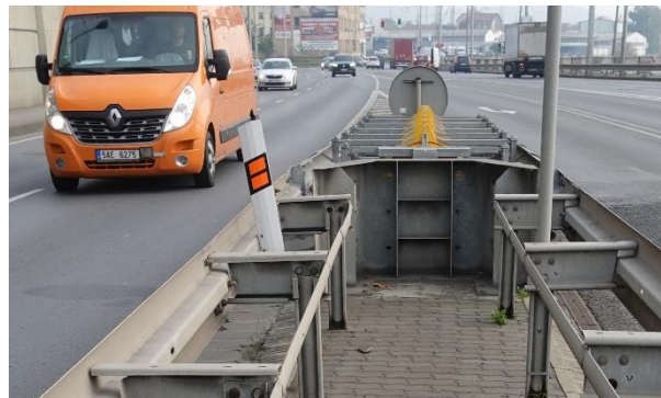
Obrázek 146 – Výhled z místa tlumiče nárazu ve směru proti příjezdu dopravního proudu.
