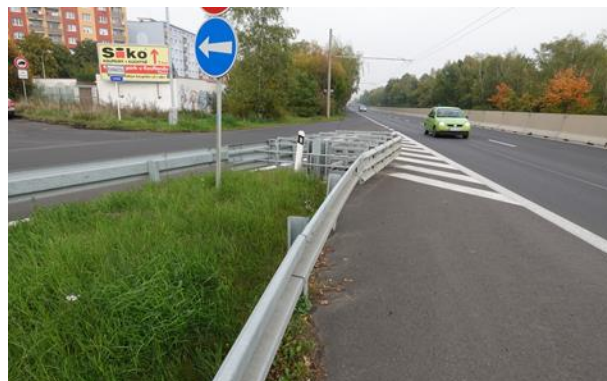
Obrázek 51 – Pohled na tlumič nárazu nacházející se v prostoru bezpečné zóny PK.
