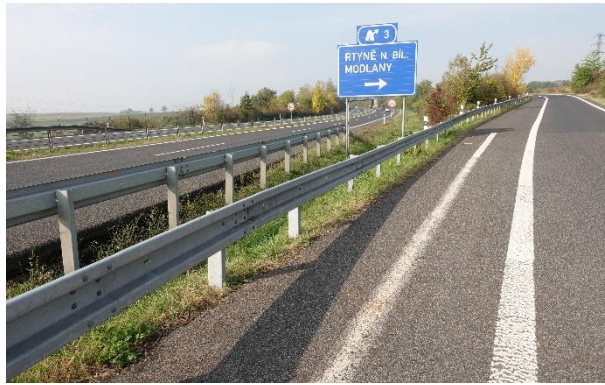
Obrázek 134 – Boční pohled na ocelová svodidla v dopravním ostrůvku MÚK z větve.
