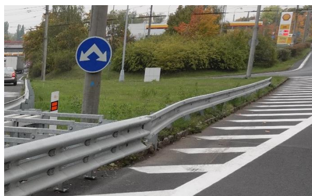
Obrázek 35 – Pohled na ocelové svodidlo v místě vedlejší větve.
