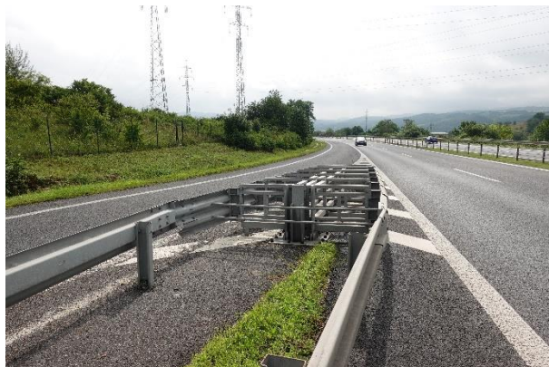
Obrázek 130 – Výhled z místa tlumiče nárazu ve směru proti příjezdu dopravního proudu.
