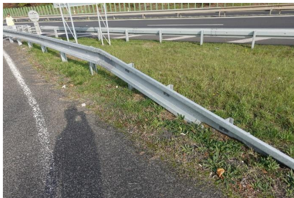
Obrázek 118 – Pohled na konec ocelových svodidel ve větvi MÚK.
