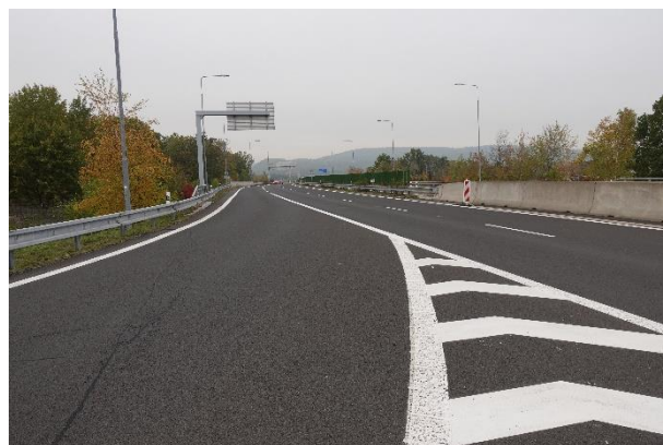
Obrázek 22 – Výhled z místa tlumiče nárazu ve směru proti příjezdu dopravního proudu.
