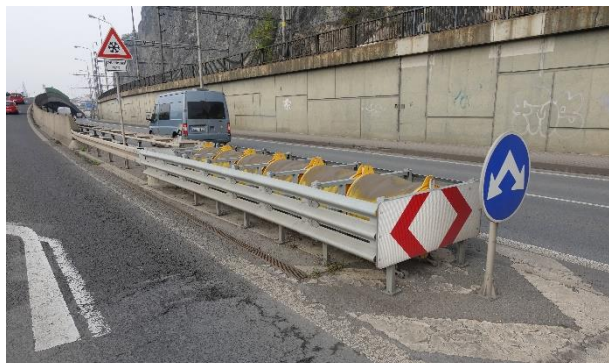
Obrázek 145 – Pohled na sledovanou lokalitu ve směru proti staničení silnice I/62.
