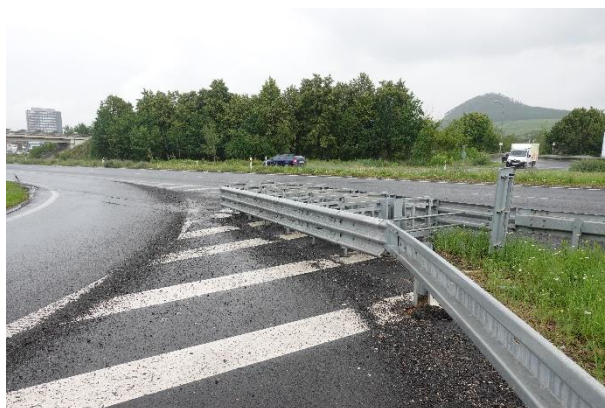
Obrázek 87 – Boční pohled na tlumič nárazu z místa větve MÚK.
