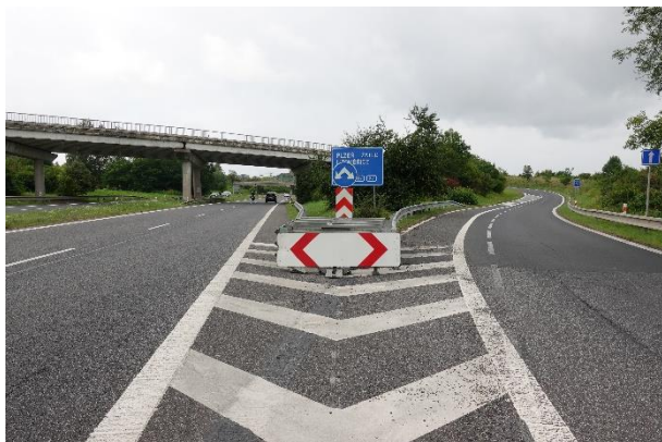
Obrázek 94 – Pohled na sledovanou lokalitu ve směru proti staničení silnice I/13.
