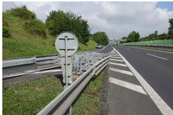
Obrázek 112 – Výhled z místa tlumiče nárazu ve směru proti příjezdu dopravního proudu.
