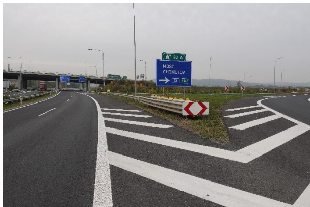
Obrázek 3 – Pohled na sledovanou lokalitu ve směru staničení silnice I/7.
