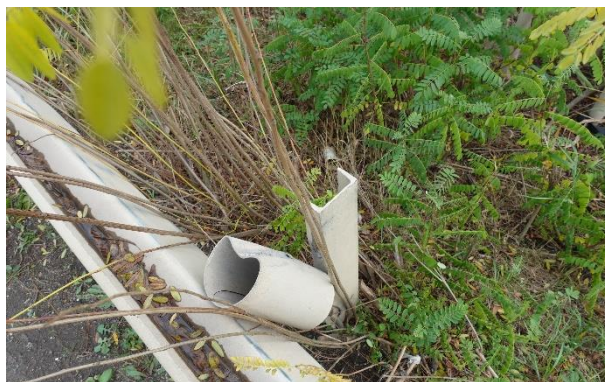
Obrázek 60 – Pohled na poškozené ocelové svodidlo podél hlavní komunikace.
