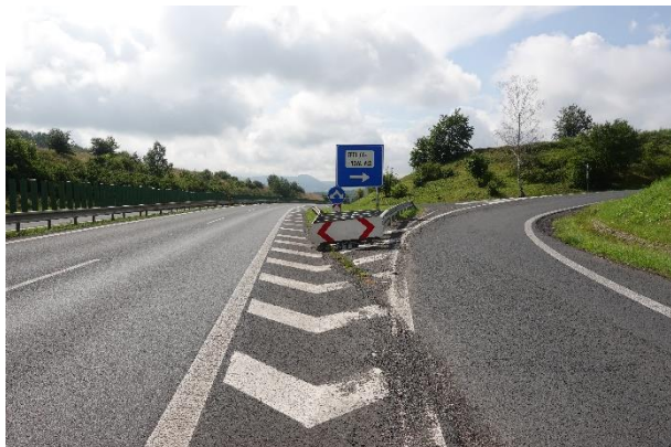
Obrázek 111 – Pohled na sledovanou lokalitu ve směru proti staničení silnice I/13.
