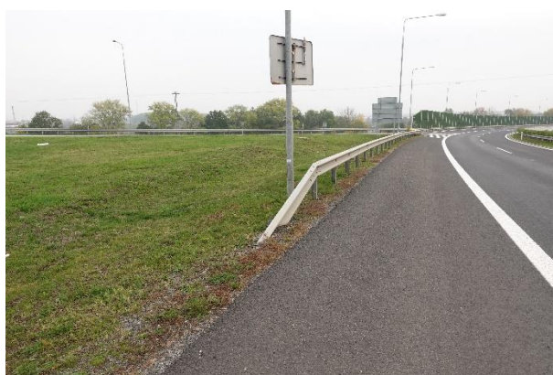
Obrázek 8 – Pohled na koncový díl ocelových svodidel, který se nachází v blízkosti sloupu VO.
