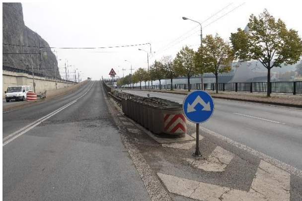
Obrázek 137 – Pohled na sledovanou lokalitu ve směru staničení silnice I/62.
