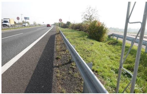
Obrázek 126 – Pohled na zakončení ocelových svodidel napojených na tlumič nárazu.
