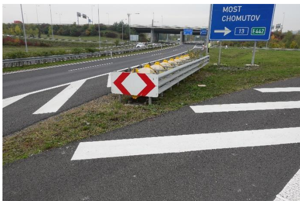
Obrázek 5 – Pohled na tlumič nárazu TAU 100 P v místě dopravního ostrůvku.
