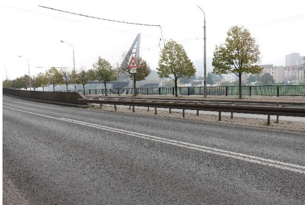
Obrázek 141 – Pohled na napojení ocelového svodidla na betonovou zeď.
