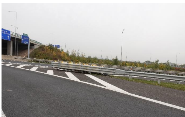
Obrázek 15 – Boční pohled na tlumič nárazu TAU 100 L v místě dopravního ostrůvku.
