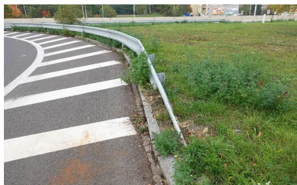
Obrázek 44 – Pohled na ocelové svodidlo v místě vedlejší větve.
