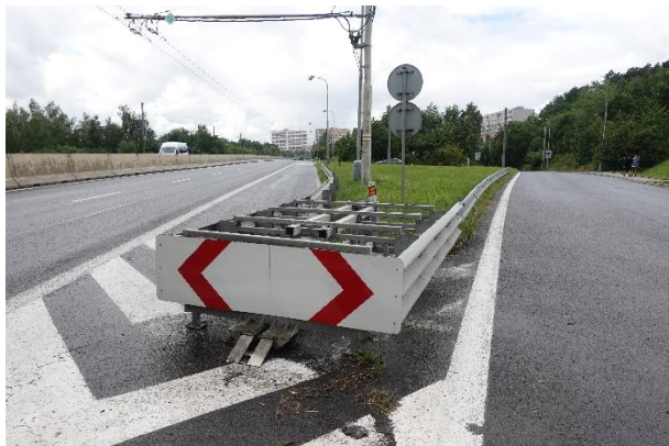
Obrázek 48 – Pohled na sledovanou lokalitu ve směru proti staničení silnice I/13.
