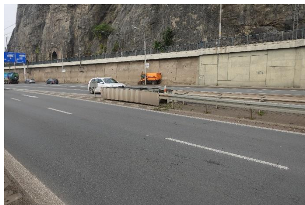
Obrázek 140 – Vzdálenější pohled na tlumič nárazu a navazující ocelové svodidlo.
