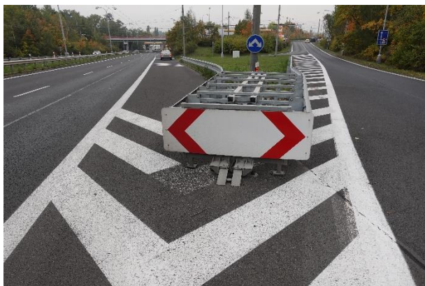
Obrázek 30 – Pohled na sledovanou lokalitu ve směru proti staničení silnice I/13.
