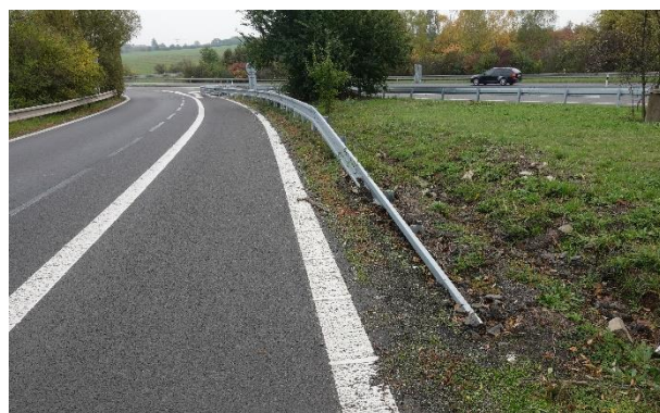
Obrázek 99 – Pohled na ukončení ocelového svodidla v místě vedlejší větve.
