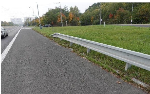
Obrázek 52 – Pohled na ukončení ocelového svodidla vedeného souběžně s hlavní komunikací.
