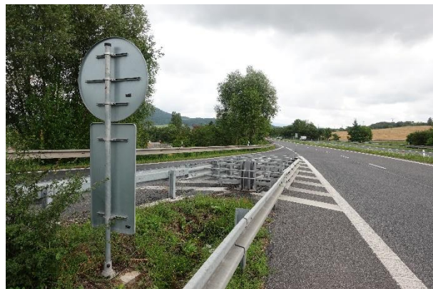
Obrázek 95 – Výhled z místa tlumiče nárazu ve směru proti příjezdu dopravního proudu.
