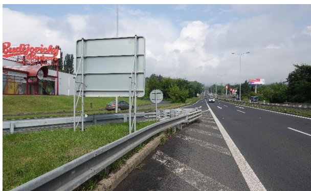
Obrázek 107 – Výhled z místa tlumiče nárazu ve směru proti příjezdu dopravního proudu.
