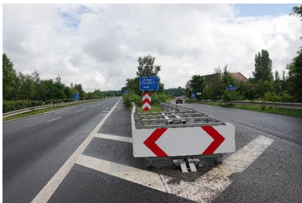
Obrázek 57 – Pohled na sledovanou lokalitu ve směru staničení silnice I/13.
