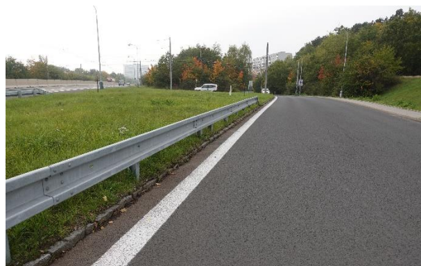
Obrázek 53 – Pohled na ocelové svodidlo v místě vedlejší větve MÚK.
