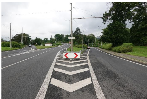
Obrázek 153 – Pohled na sledovanou lokalitu ve směru proti staničení silnice I/62.
