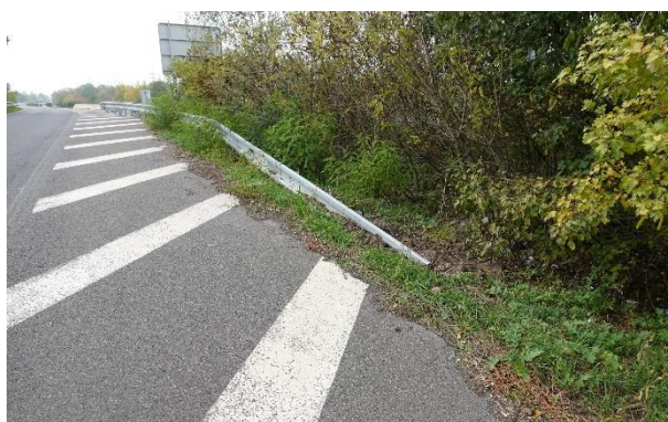
Obrázek 62 – Ukončení svodidla ve větvi MÚK.
