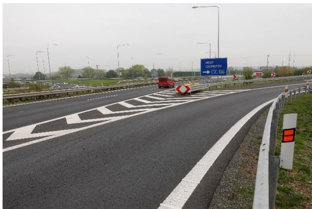
Obrázek 13 – Pohled na sledovanou lokalitu ve směru proti staničení silnice I/7.
