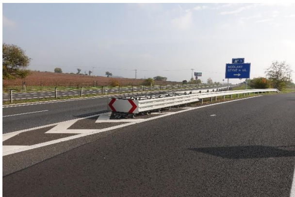
Obrázek 121 – Pohled na sledovanou lokalitu ve směru staničení silnice I/63.
