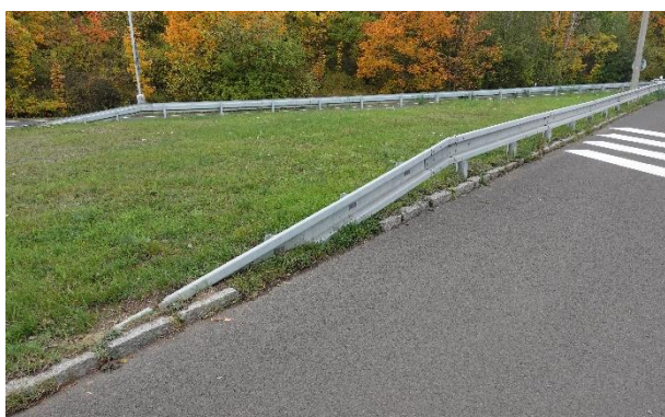
Obrázek 34 – Pohled na ukončení ocelového svodidla na hlavní silnici.
