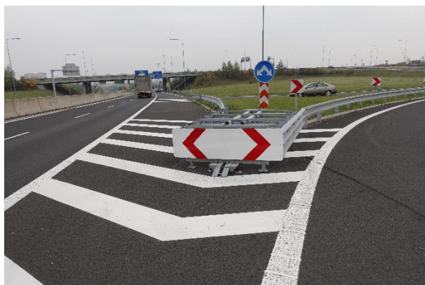
Obrázek 21 – Pohled na sledovanou lokalitu ve směru proti staničení silnice I/7.
