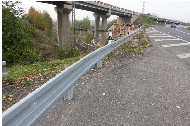
Obrázek 73 – Pohled na napojení nového svodidla na stávající ocelové svodidlo.
