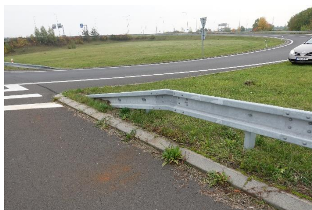
Obrázek 26 – Pohled na koncový díl svodidel.
