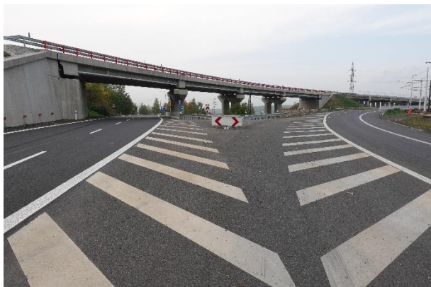
Obrázek 66 – Pohled na sledovanou lokalitu ve směru proti staničení silnice I/13.
