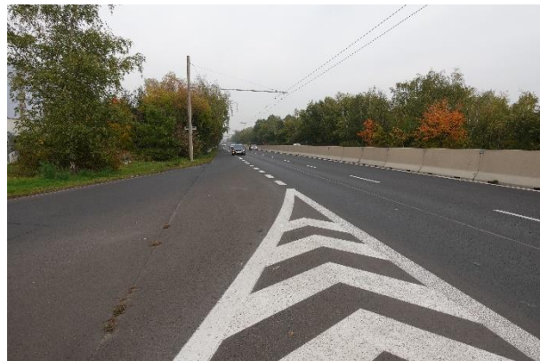
Obrázek 49 – Výhled z místa tlumiče nárazu ve směru proti příjezdu dopravního proudu.
