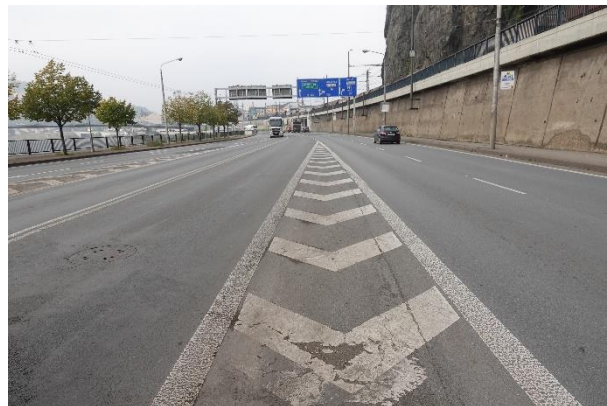
Obrázek 138 – Výhled z místa tlumiče nárazu ve směru proti příjezdu dopravního proudu.
