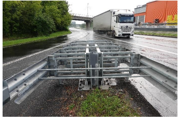
Obrázek 77 – Výhled z místa tlumiče nárazu ve směru proti příjezdu dopravního proudu.
