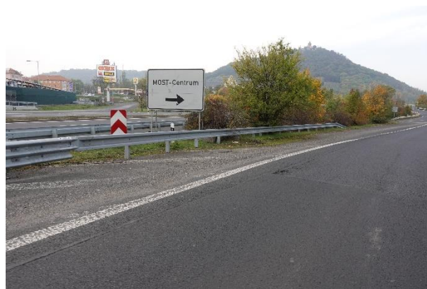
Obrázek 83 – Pohled na konec ocelových svodidel ve větvi MÚK.
