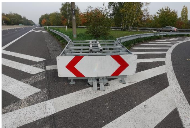
Obrázek 39 – Pohled na sledovanou lokalitu ve směru staničení silnice I/13.
