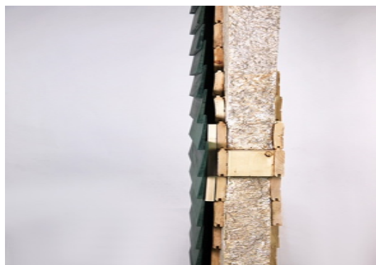
Obr. 06: Ecovative, detail vnitřku stěny Mushroom Tiny House
